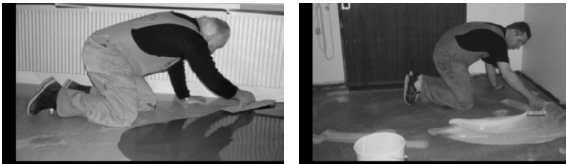
Figure 17. Poseurs de plancher, remplissage traditionnel. Tirée de Jensen et al. [121].
