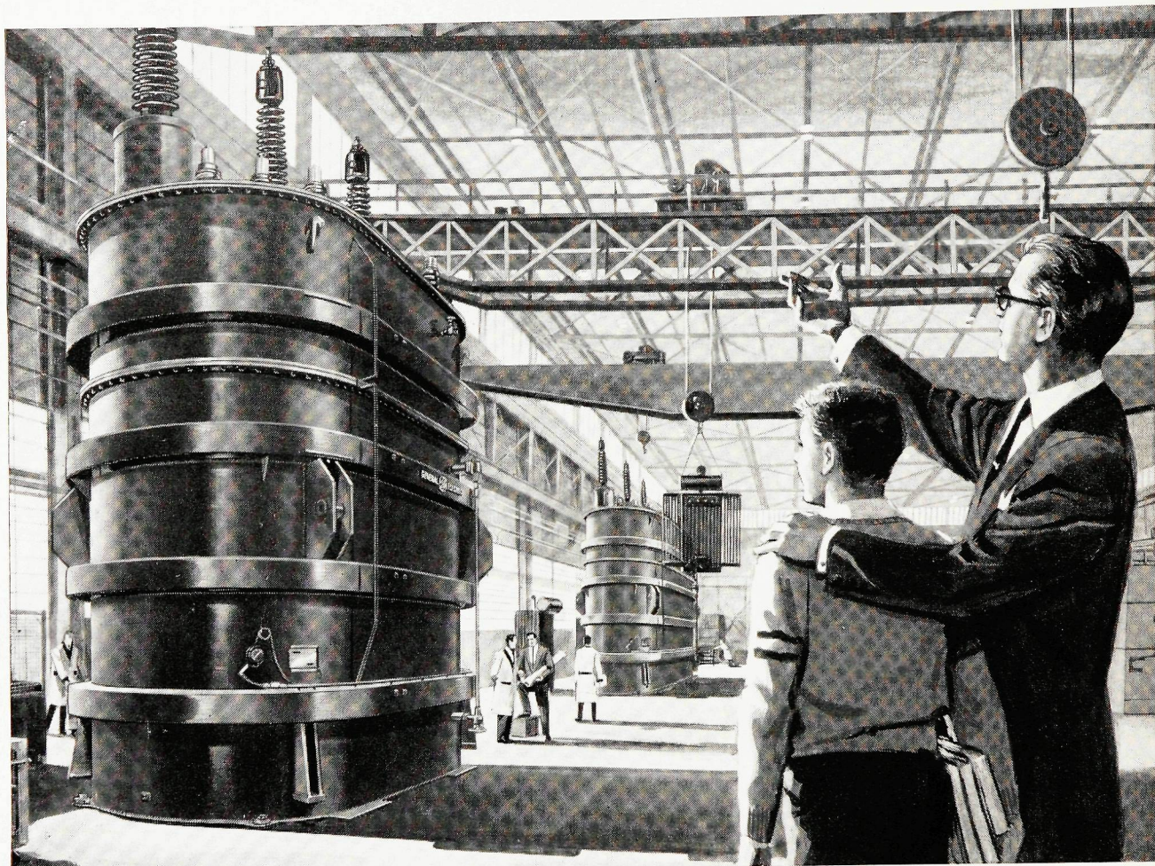
Usine des transformateurs C.G.E. à Guelph, Ontario
