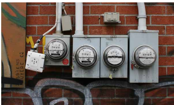
Figure 72 : Compteurs électriques analogiques.
