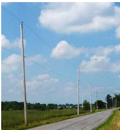
Figure 64 : Réseau de distribution aérien dans sa forme la plus simple. Comporte ici un seul service transmis par câble en milieu à faible densité de clientèle.
