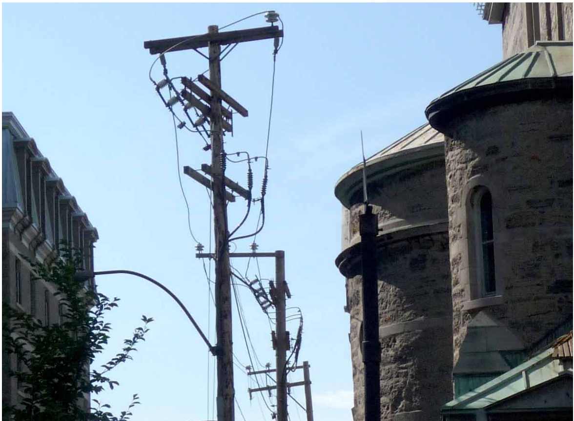
Figure 39 : Entrée aérosouterraine du réseau de distribution de services transmis par câbles. En voici un exemple, situé en bordure d'une église à l'angle Rachel et Henri-Julien.
