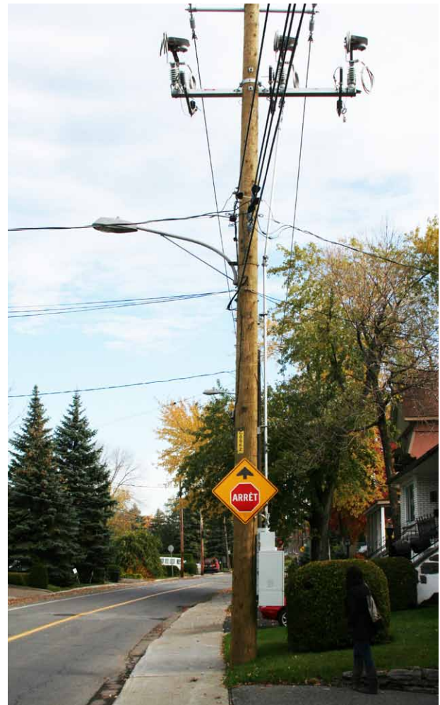
Figure 8 : Boîtier de commande d'automatisation pour interrupteur triphasé d'Hydro-Québec.
