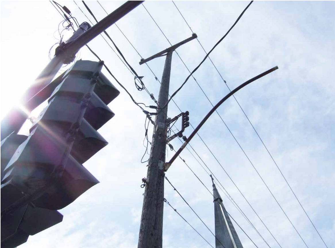
Figure 69 : Équipements résiduels. Potence de système d'éclairage laissée sur place malgré l'installation de lampadaires indépendants sur la voie publique.
