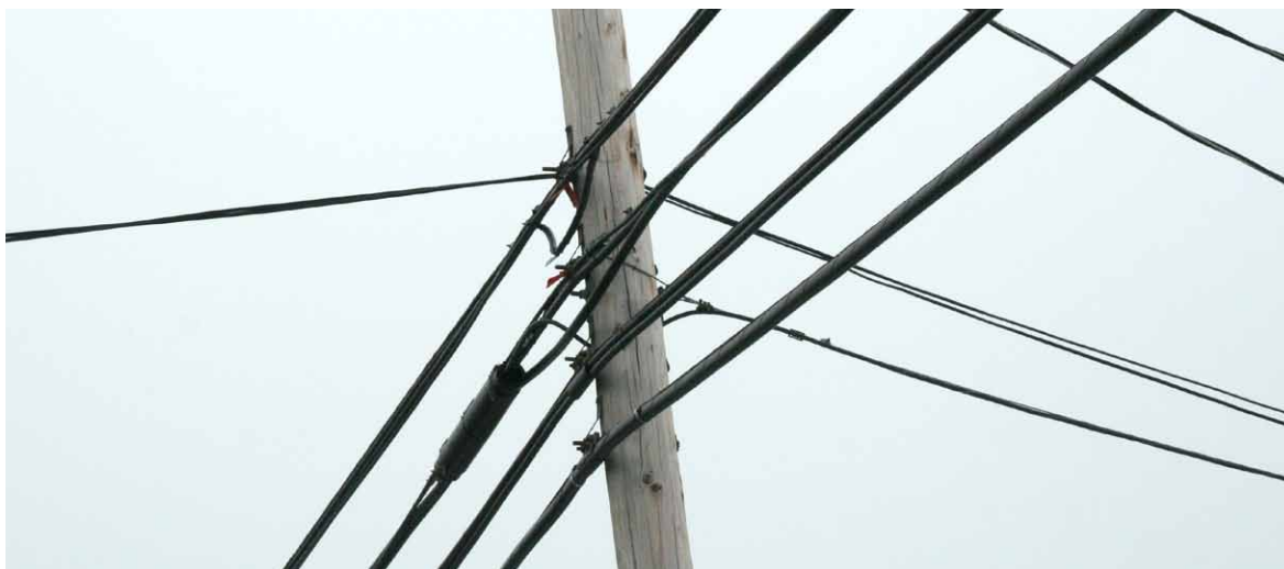
Figure 3 : Câbles de transmissions de services électrique, de téléphonie et câblodistribution.
