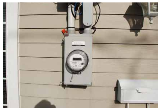
Figure 73 : Compteur électrique numérique.
