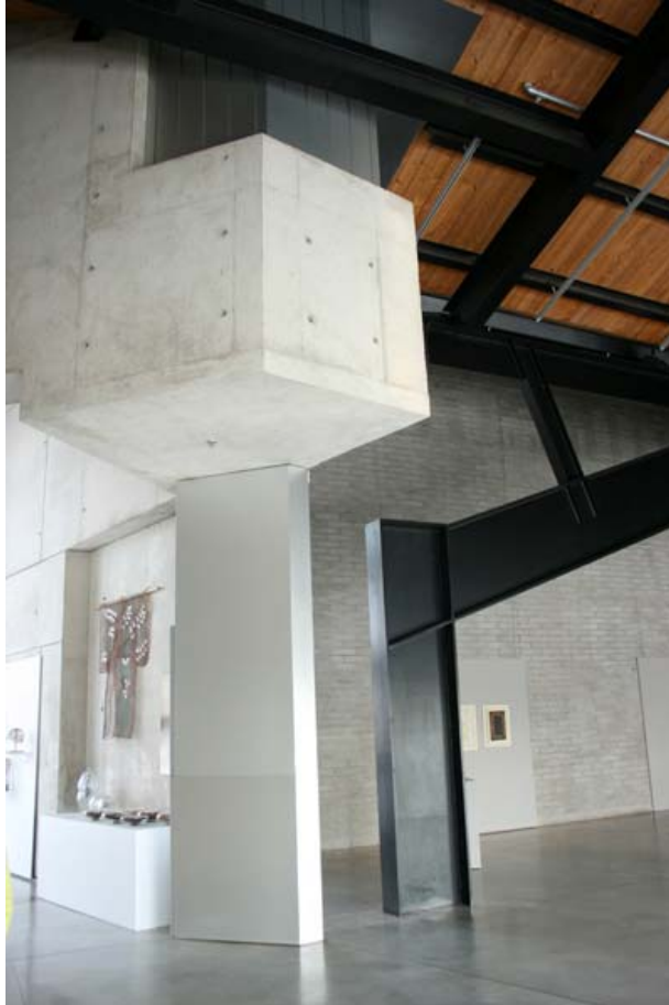
Figure 39 : Galerie canadienne de la céramique et du verre, projet de Patkau Architects (1986). Détail du support incliné de la poutre principale et de l'intersection du volume de l'espace d'exposition des travaux en verre teinté. Photo de l'auteur, 2008
