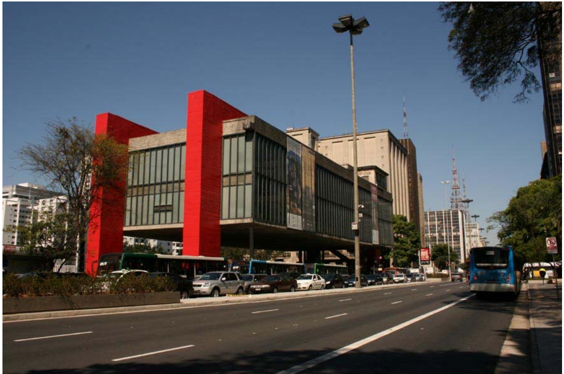
Figure 82 : Musée d'art de Sao Paulo, MASP, projet de Lina Bo Bardi (1957). Projet qui explore le thème de la boîte suspendu par un portique de béton armé de 74m d'envergure. Photo de l'auteur, 2008
