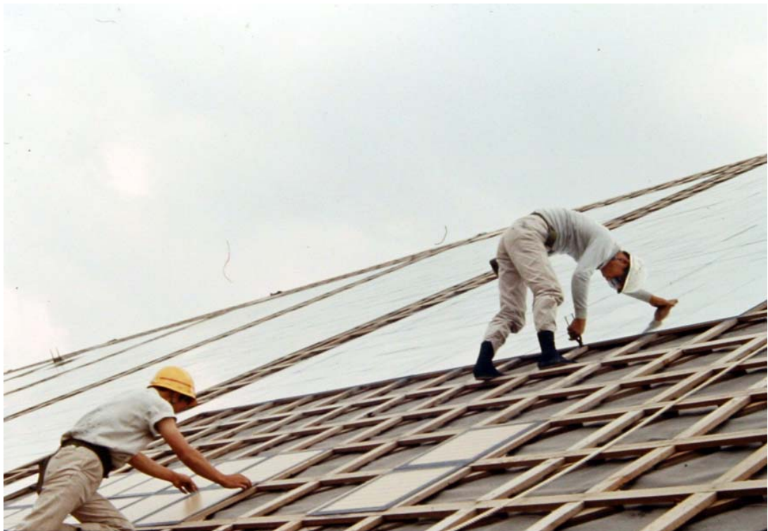
Figure 149 : Pavillon du Canada à l'Expo Osaka 1970, projet d'Arthur Erickson et Geoffrey Massey (1967). Photo du chantier montrant la pose du revêtement miroité sur le solivage de bois, 1969. Source : Fonds d'Archives Erickson, CCA
