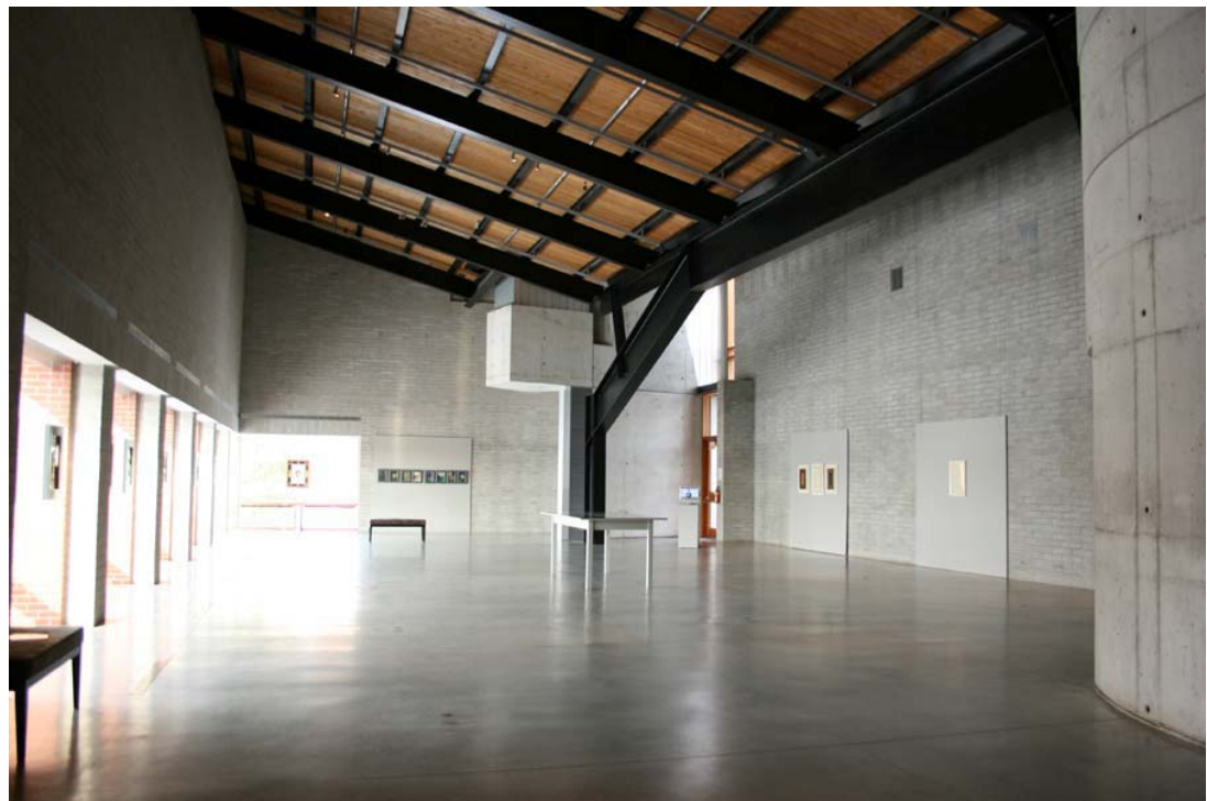
Figure 34 : Galerie canadienne de la céramique et du verre, projet de Patkau Architects (1986). Deux vues de la salle d'exposition où l'on peut remarquer (1) la toiture à écoulement central avec sa poutre longitudinale; (2) le cylindre de la salle des petits travaux; (3) la variété de matériaux utilisés : béton armé coulé sur place, blocs de béton, brique, métal et bois. Photos de l'auteur, 2008.
