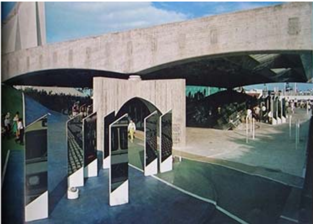
Figure 178 : Pavillon du Brésil à l'Expo Osaka 1970, projet de Paulo Mendes da Rocha et associés (1969). Vue du pilier symbolique sous la forme de deux arches croisées. Source : EXPO '70, Expo '70 = Nihon Bankoku Hakurankai, Tokyo, Kokusaijōhōsha, 1970.
