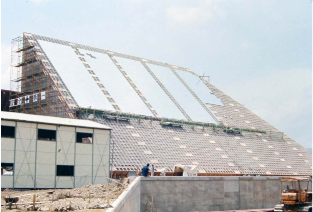
Figure 148 : Pavillon du Canada à l'Expo Osaka 1970, projet d'Arthur Erickson et Geoffrey Massey (1967). Photo du chantier au milieu de l'installation du revêtement miroité, 1969. Source : Fonds d'Archives Erickson, CCA
