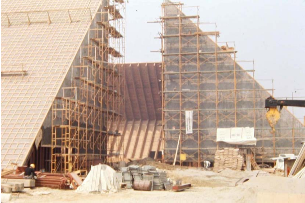
Figure 146 : Pavillon du Canada à l'Expo Osaka 1970, projet d'Arthur Erickson et Geoffrey Massey (1967). Photo du chantier le 26 avril 1969. Source : Fonds d'Archives Erickson, CCA
