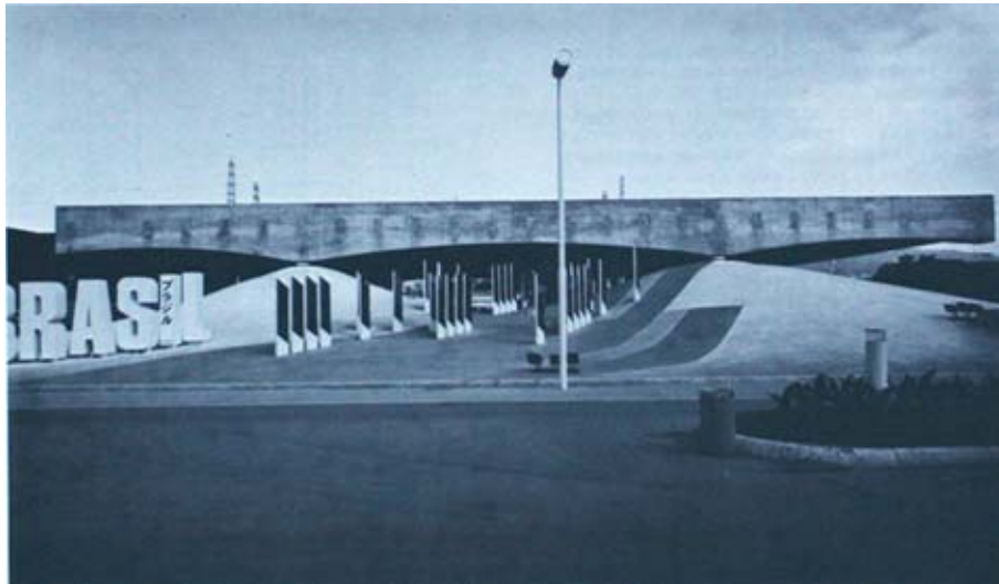
Figure 154 : Pavillon du Brésil à l'Expo Osaka 1970, projet de Paulo Mendes da Rocha (1969). Vue de l'accès principal. Source : Zuchu Expo'70 (Atlas), 1969
