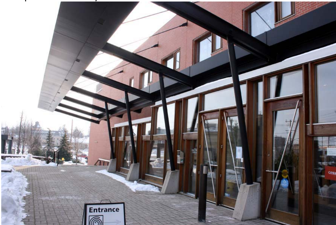
Figure 36 : Galerie canadienne de la céramique et du verre, projet de Patkau Architects (1986). La marquise d'entrée en métal reste suspendue au mur et appuyée sur des supports indépendants de l'enveloppe externe. Photo de l'auteur, 2008
