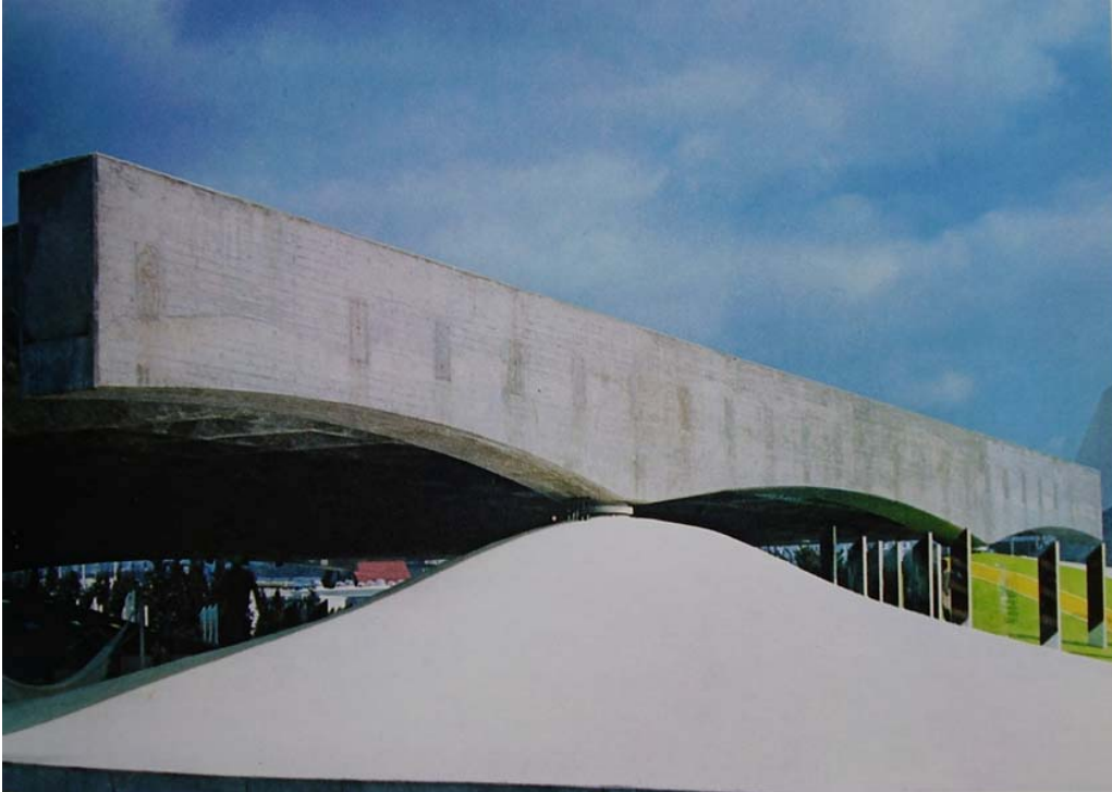
Figure 177 : Pavillon du Brésil à l'Expo Osaka 1970, projet de Paulo Mendes da Rocha et associés (1969). Vue d'une ondulation du terrain et du joint flexible. À remarquer dans la poutre principale les marques du coffrage et la disposition des éléments de postcontrainte. Source : The edifice in Expo '70. 2 vols, Osaka, 1969.
