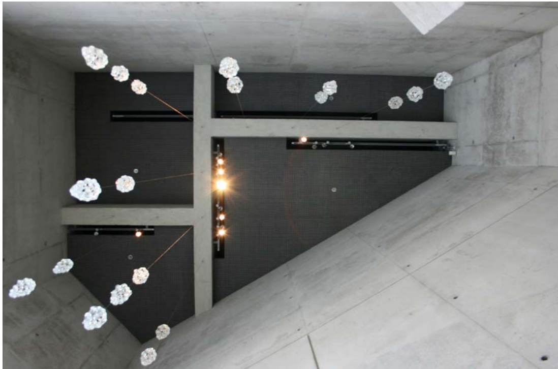
Figure 37 : Galerie canadienne de la céramique et du verre, projet de Patkau Architects (1986). Toit de la salle d'exposition des travaux en verre teinté où l'on voit la disposition orthogonale de trois poutres à l'intérieur d'un volume irrégulier, vue en contreplongée. Photo de l'auteur, 2008
