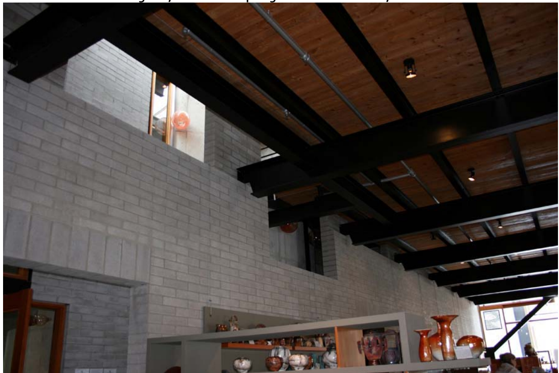
Figure 38 : Galerie canadienne de la céramique et du verre, projet de Patkau Architects (1986). Vue du hall d'entrée où l'on voit le plancher suspendu du premier étage. Ce plancher fait de bois et de structure métallique vient s'appuyer très légèrement dans les murs latéraux. Photo de l'auteur, 2008
