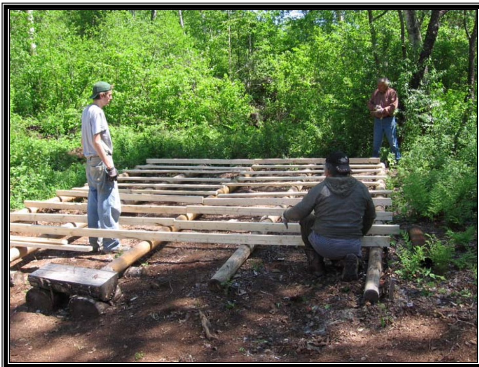
Photo 4. Construction d'un plancher d'habitation. Camp Rhéaume, 2007.
