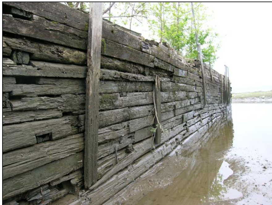
Figure 14. Parement de longrines du quai de Trois-Saumons
