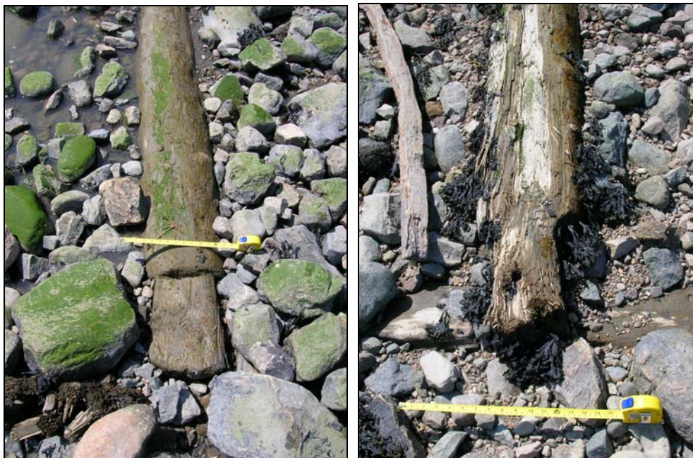
Figure 23. Extrémités de traversins au quai du cap aux Corbeaux. Malgré l'érosion subie par les vestiges, on peut encore apercevoir que les pattes des traversins ont été travaillées en « queue d'aronde ».
