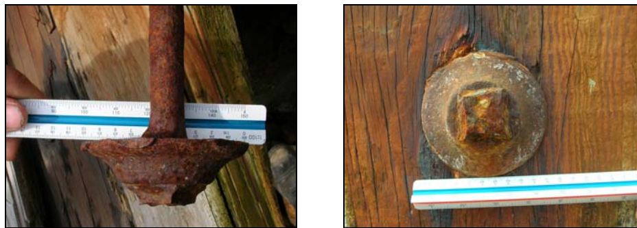
Figure 66. Boulons écroués de type « gouvernemental » On reconnaît les boulons écroués de type « gouvernemental » par leurs disques d'appuie en forme de chapeau. Photos: Frédéric Simard
