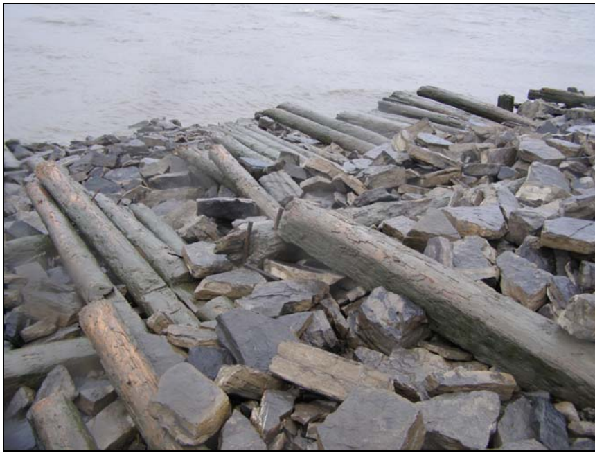
Figure 46. Radier de billots à l'extrémité distale des vestiges.
