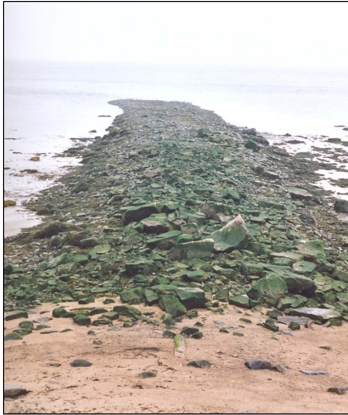
Figure 18. Vestiges du quai du cap aux Corbeaux vus de la voie ferroviaire.
