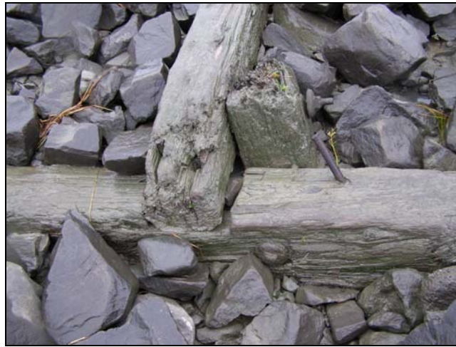
Figure 54. Vue rapprochée du mode de liaison (Cap-Saint-Ignace) On y trouve l'empâtement croisé, les clous et les boulons écroués. Photo : Frédéric Simard
