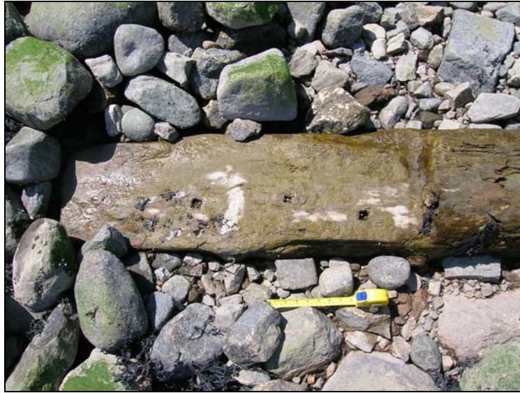
Figure 25. Traces de clou repérées au quai du cap aux Corbeaux.
