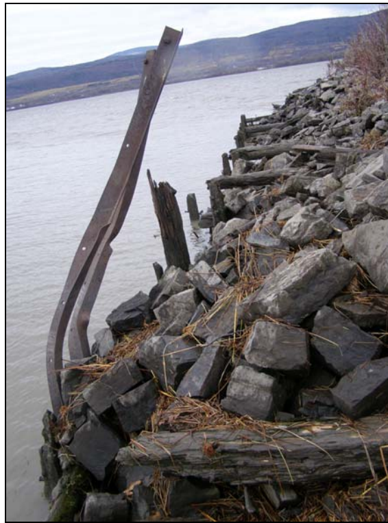
Figure 45. Vue du flanc ouest du quai de Sainte-Famille. Les deux montants d'une échelle témoignent de la hauteur d'origine du quai. Photo: Frédéric Simard
