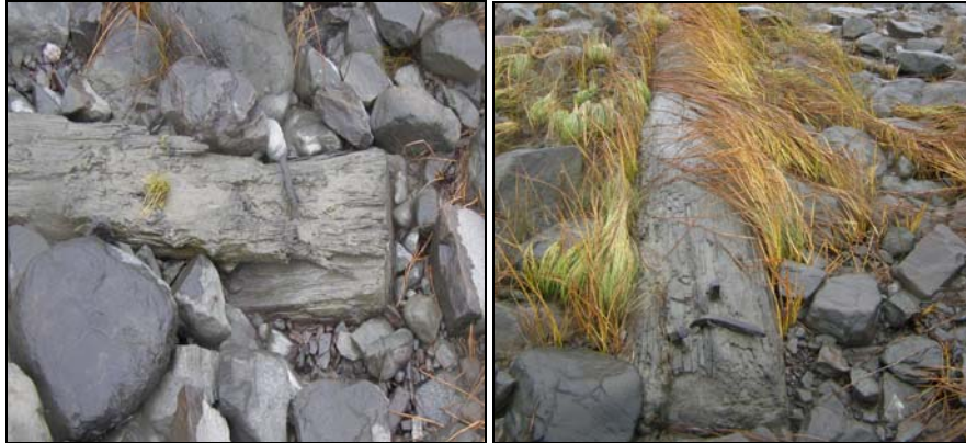
Figure 33. Extrémités des traversins au quai Méhote
