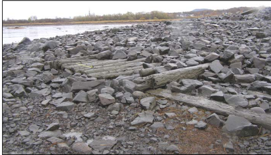
Figure 58. Radier de billots à l'extrémité distale des vestiges (Cap-Saint-Ignace)
