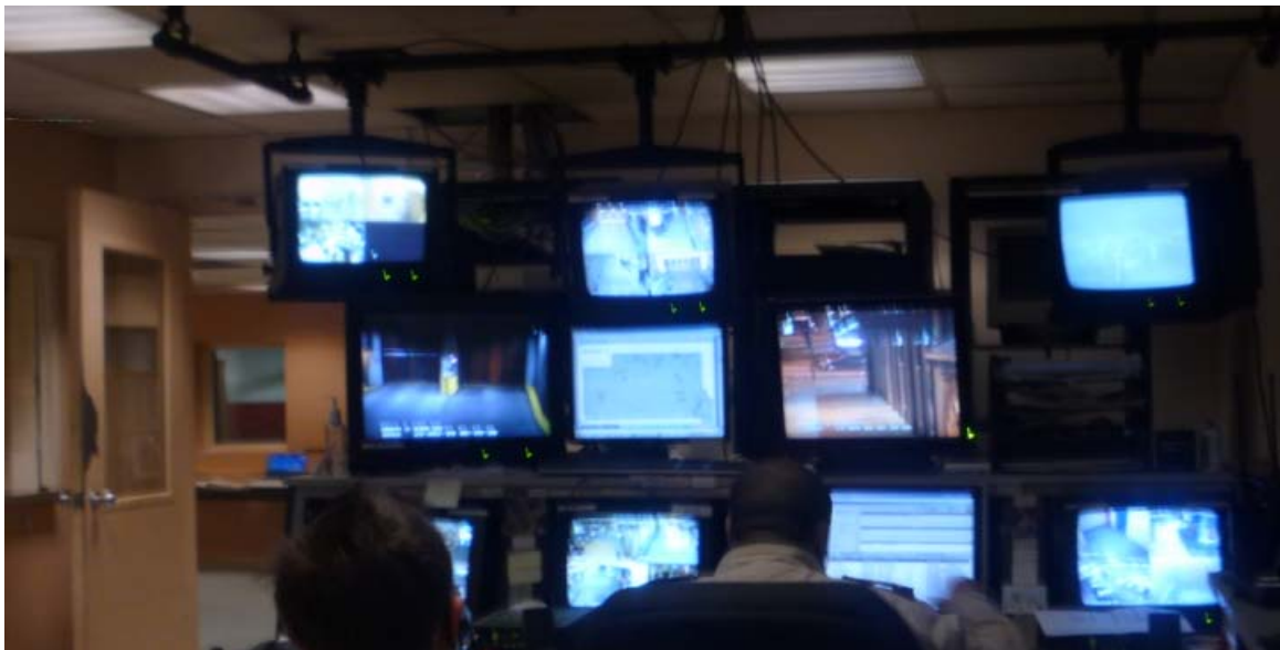
Figure 3. 2 : Disposition des écrans dans la salle de contrôle
