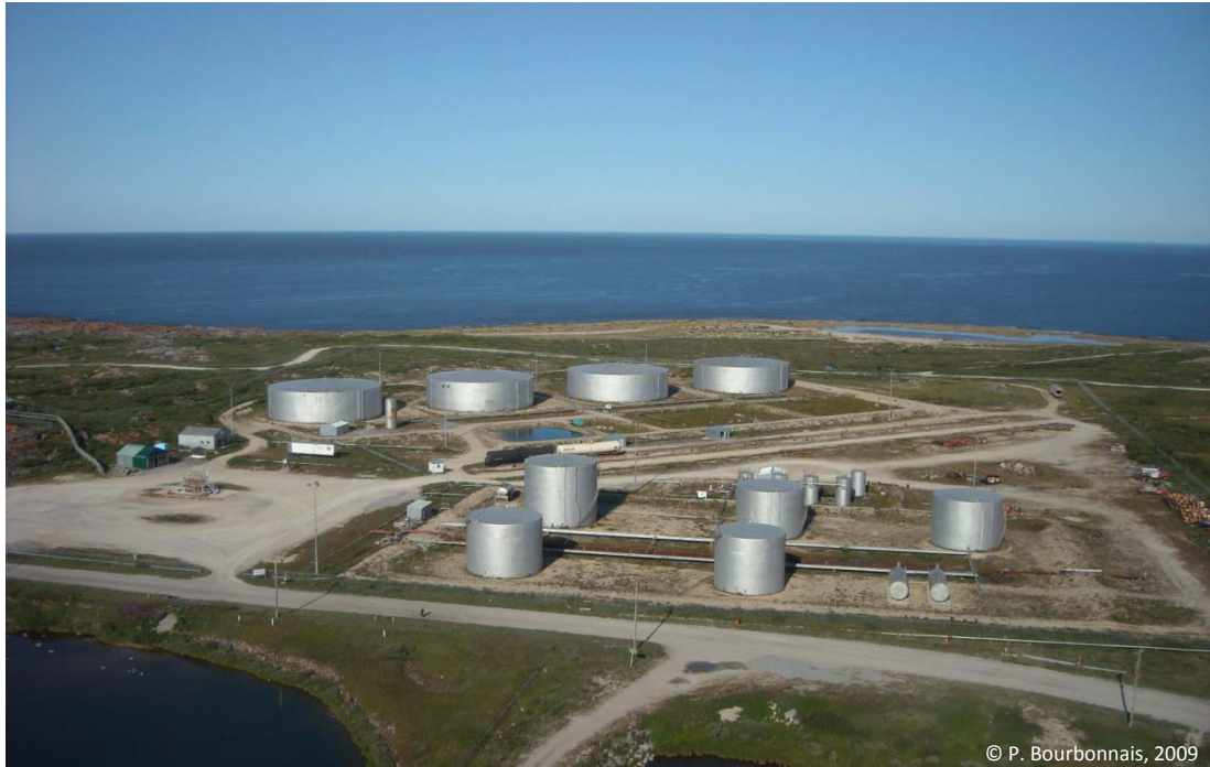
Figure 20. Complexe d'entreposage du vrac liquide du port de Churchill.
