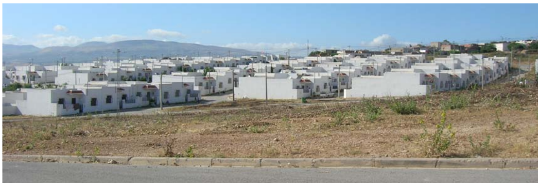
Vue générale des villas groupées d'Errous. (Photo : Bouraoui, 2009-05-28)
