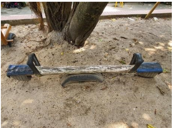
9-E : Module en matériaux recyclés dégradés
