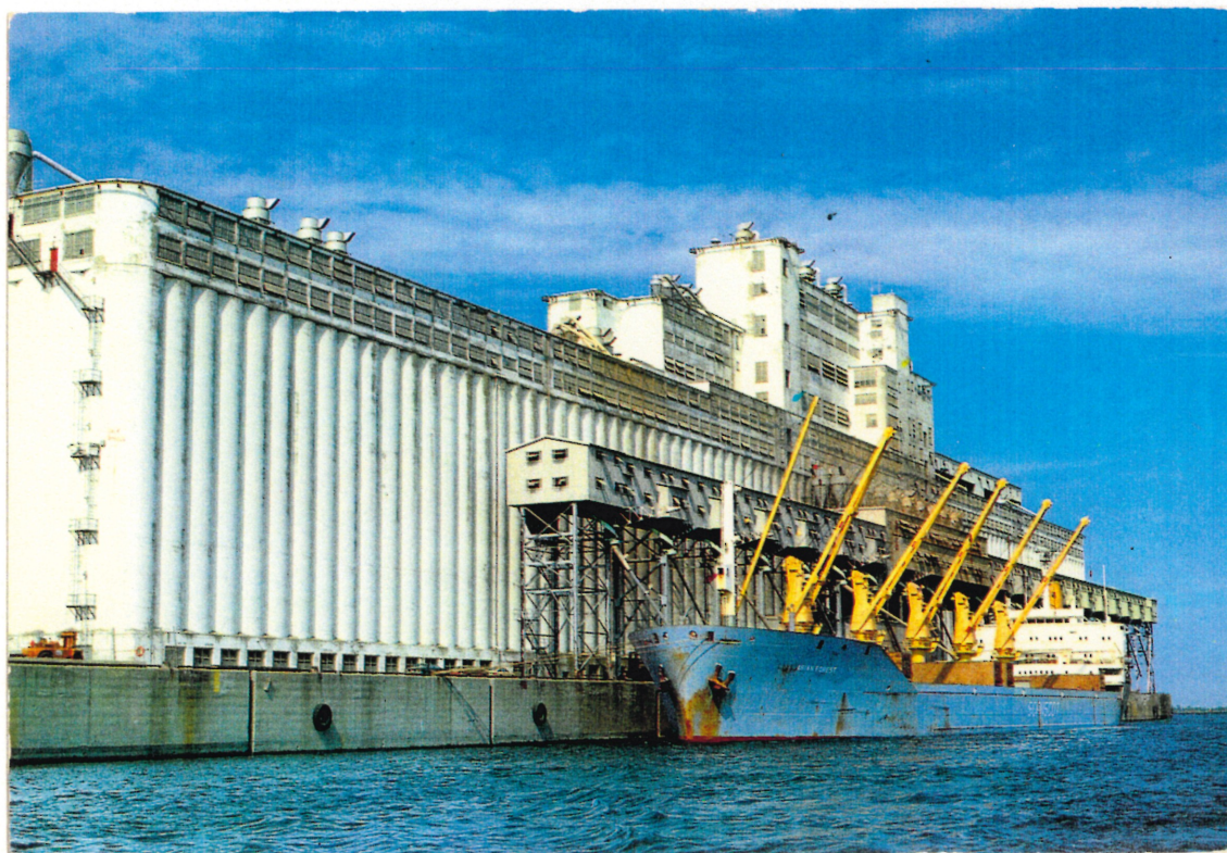
Fig. 38: Silos à grains du port de Montréal.
