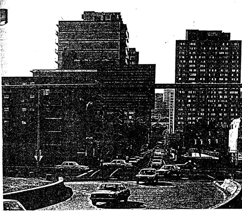
Fig. 35: Vue vers le nord dans l'axe de la rue Du Fort à partir de la Colonne onze.
