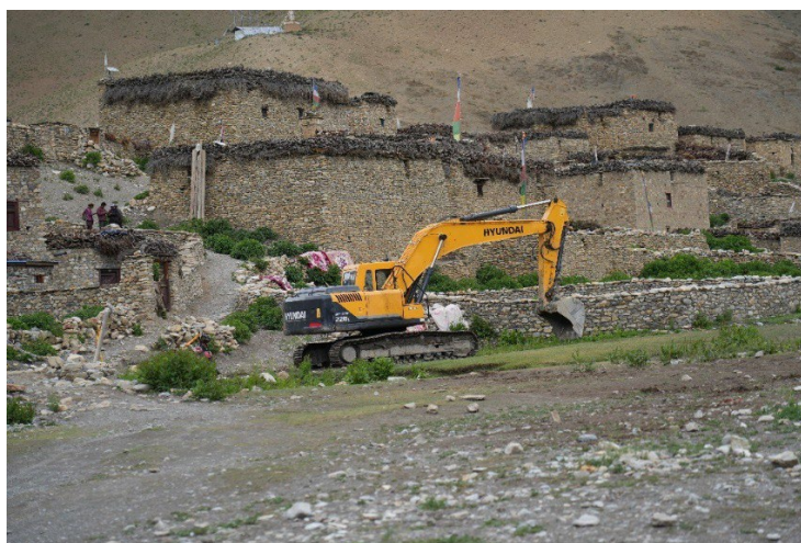
Figure 5 Présence d’un bulldozer dans le village de Dho.
