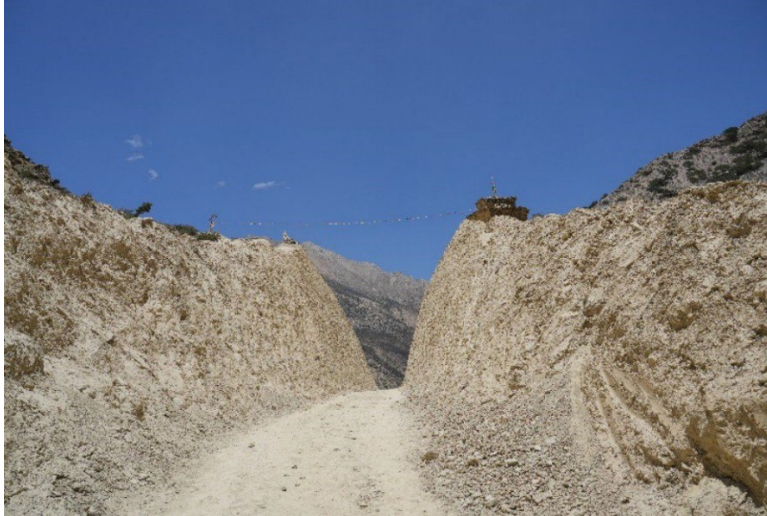
Figure 27 Nouvelle route construite sur le col de Shisshol
