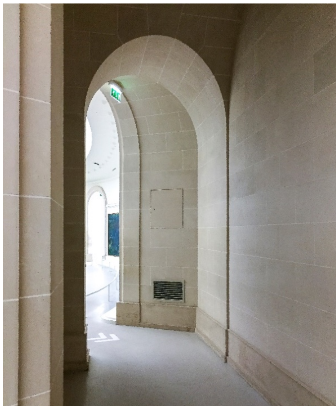
Figure 13 : Tunnel incurvé reliant les deux salles de la galerie des Nymphéas, Musée de l'Orangerie
