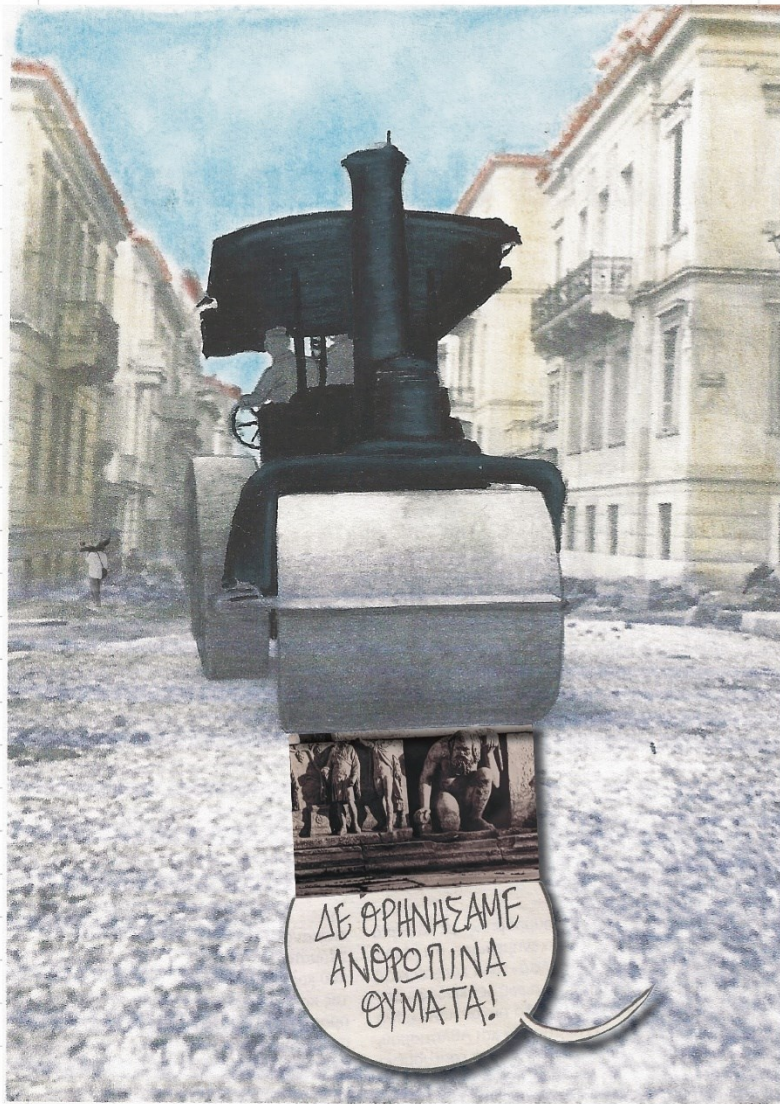
Ασφαλτόστρωση δρόμου στο Κολωνάκι 1920
