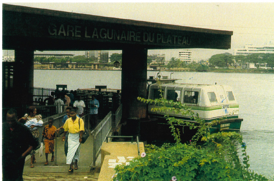
Photo 6 : Présentation de la gare lagunaire de bateau bus
