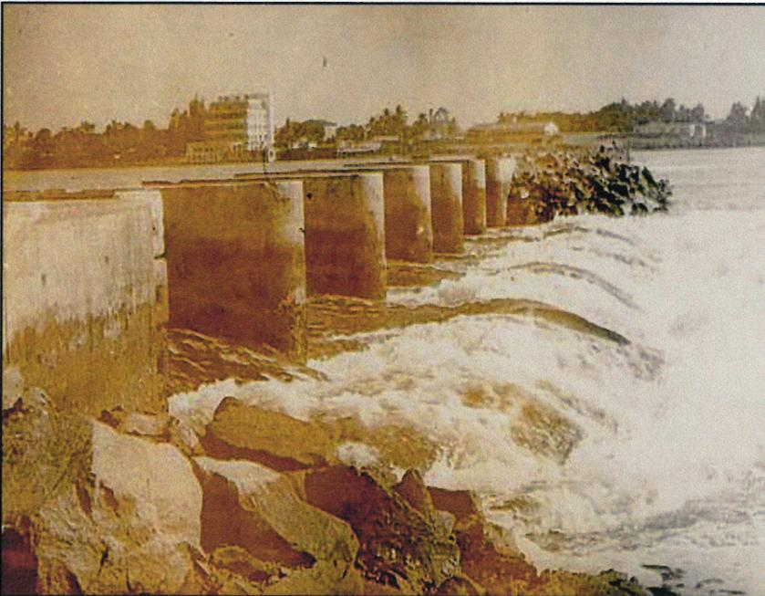
Cette partie du barrage est constituée par 6 pertuis de 4,50 mètres de large fermés par des putrelles de bouclure en béton armé. Le sommet de l'évacuateur se trouve à 1,50 mètres à la côte.
