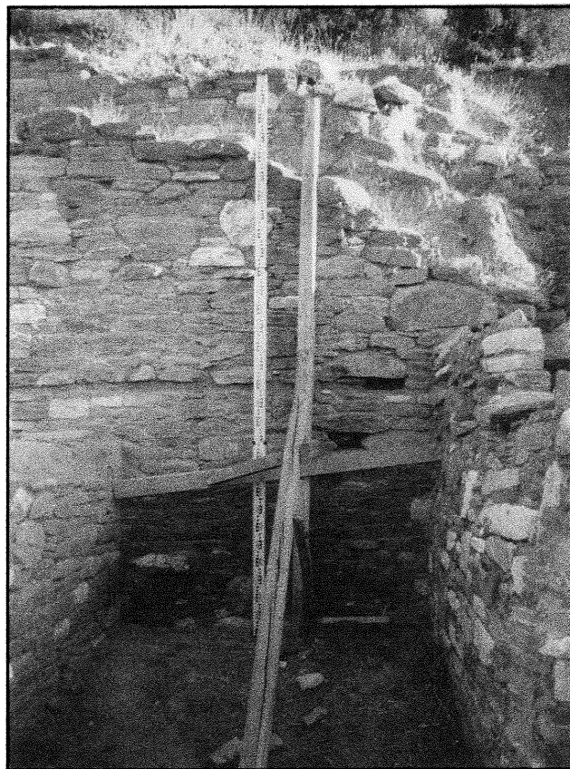
2. Mur D, partie est dans la pièce 3, paroi intérieure, vue du sud
