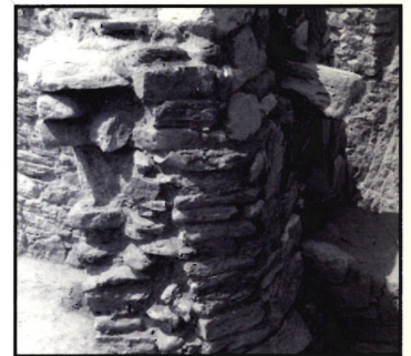
10. Pierre en saillie et angle à 45 degrés, mur E, vue du nord-est
