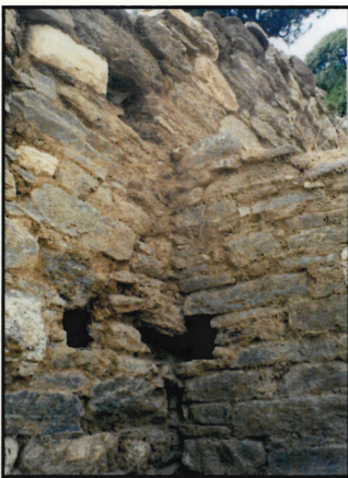
6. Trous des murs B et E, vue du sud-est
