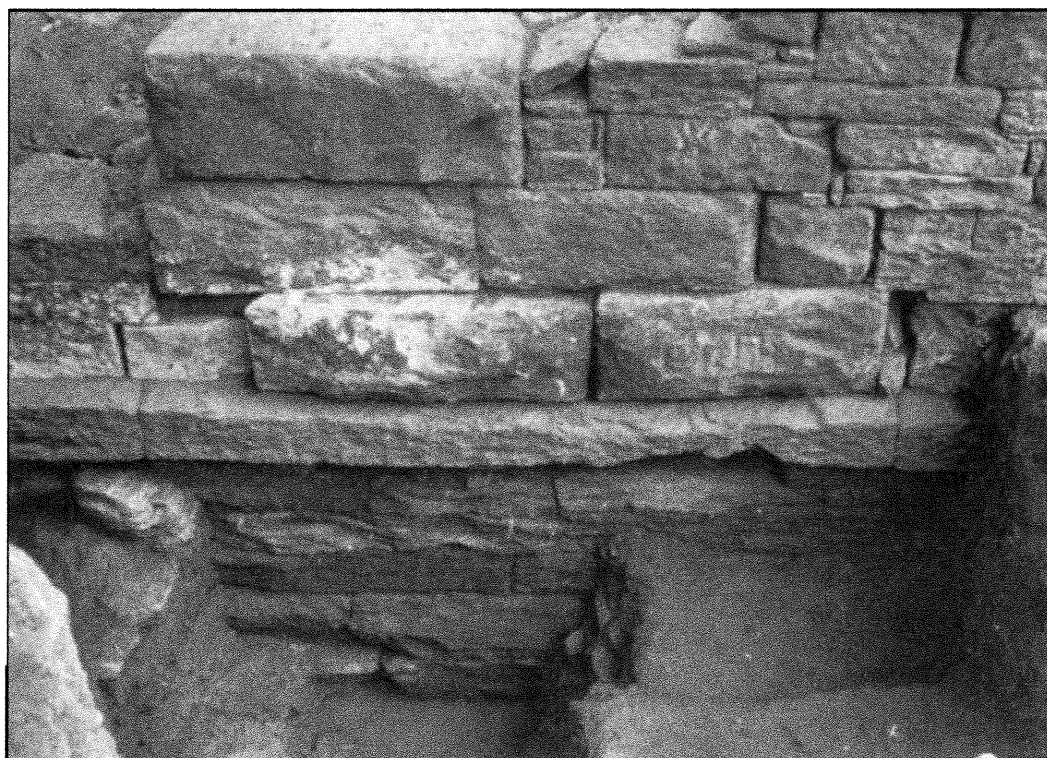
2. Quartier de la porte du Silène, Thasos, mur de façade E, paroi extérieure, îlot I. Pierre taillée à 45 degrés ouvrant sur une ancienne porte qui fut murée ultérieurement
