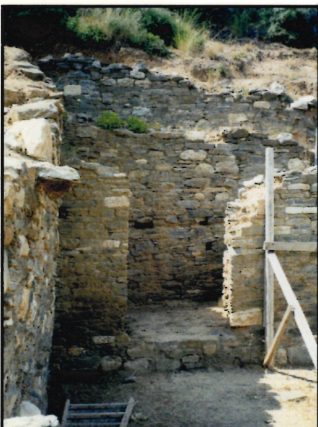
7. Pierres en saillie du mur B, vue du sud
