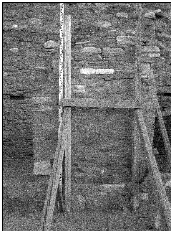
2. Mur E, pan central, vue du sud
