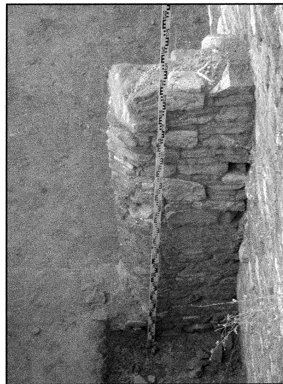
4. Mur E, pan ouest, vue du nord
