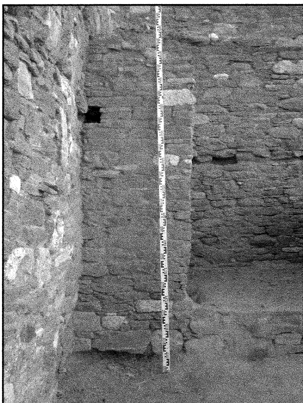
1. Mur E, pan ouest, vue du sud
