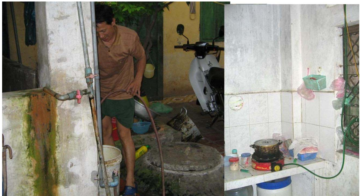
Figure 22 : Réacteur au biogaz près de l'enclos des animaux. Figure 23 : Cuisine au biogaz (photos : Julie Beauséjour)
