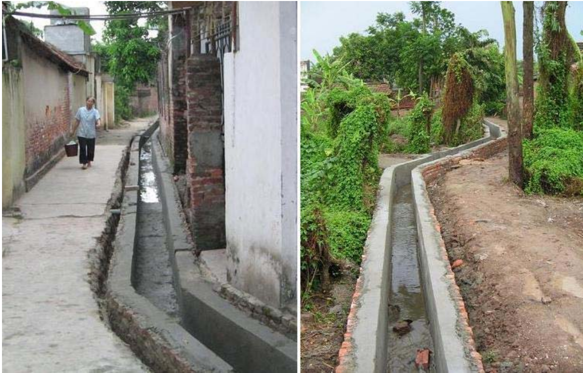
Figure 28 : Construction de l'égout principal sur rue et sur terre privée (photos : Julie Beauséjour)
