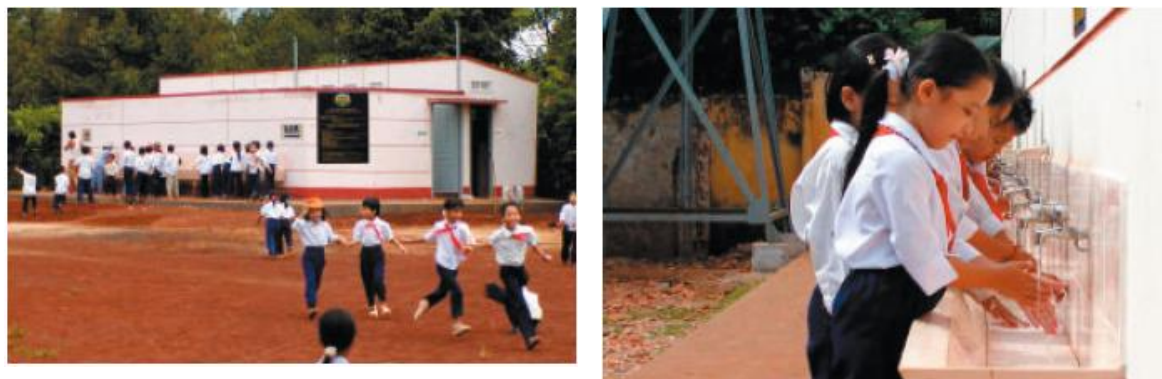
Figure 16 : Latrines d'école primaire construites dans le cadre du projet de Buon Ma Thuot ( source : Chung (2004))
