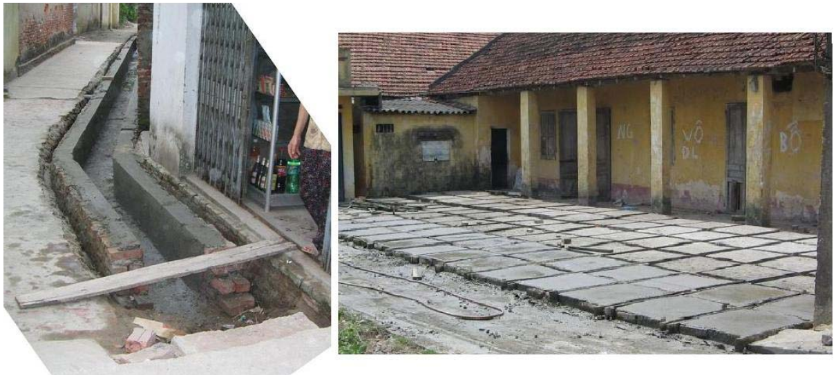
Figures 29 : Construction de l'égout et des plaques (photos : Julie Beauséjour)
