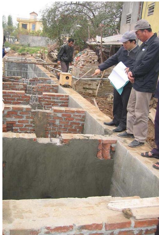
Figure 32 : Construction d'une fosse septique commune pour 80 ménages à Lai Xà (2006)
