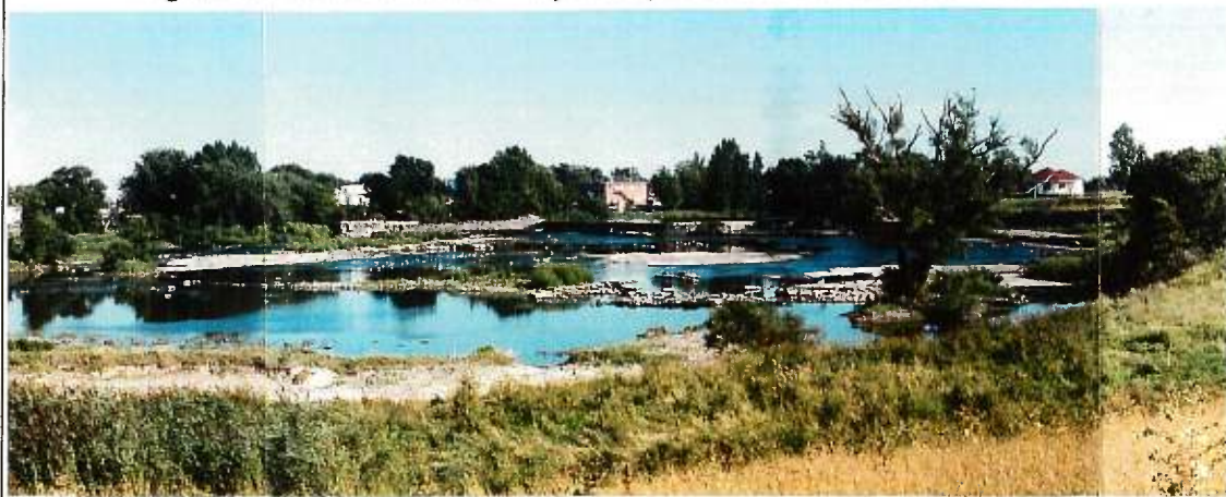
Figure 64: Le site de l'ancien noyau de production industrielle du faubourg.
