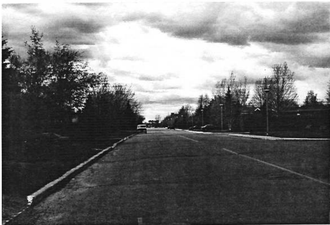
Figure 41: La rue Lafleur. Nous voyons l'espace distendu des lotissements édifiés de type « C » à cause de la largeur de la partie carrossable de la voie (17 mètres) et du recul considérable du bâti. L'emprise publique de la voie est de 25 mètres.
