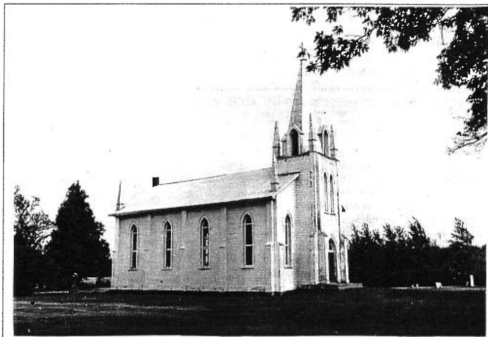
Figure 5: L'église anglicane St. Paul située à Saint-Félix-de-Kingsey est caractéristique du renouveau gothique du 19 e siècle. Bâtie en plein champ, elle est aujourd'hui fermée et en décrépidité.
