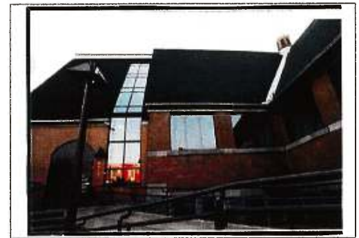
Figure 14: Ancienne église de l'Ascension (avenue Parc, Montréal). Volume additionnel ajouté à la partie sud.
