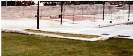
Fondations hexagonales en béton de la logette de l'éclusier
