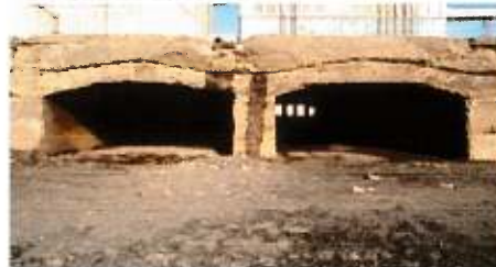
Les deux corridors
