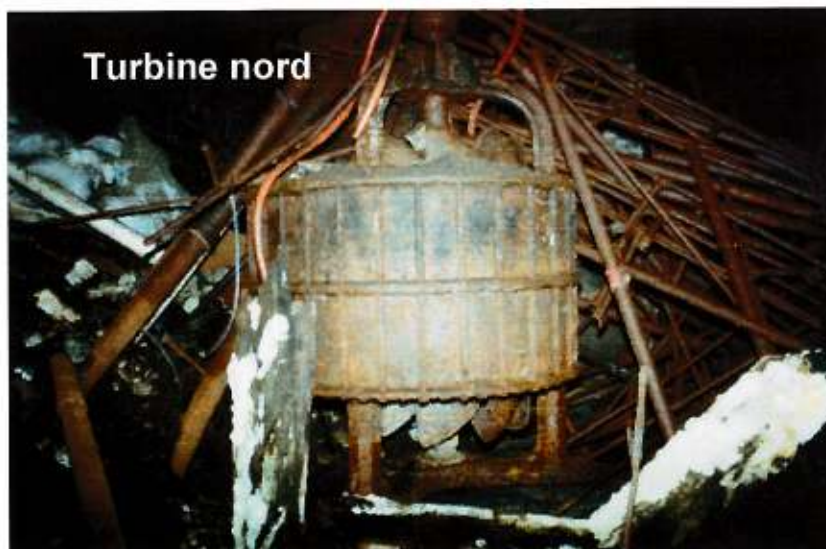
Figure 47 : Turbines «Little Giant» dans le sous-sol de la Meunerie Rozon en 1993.
