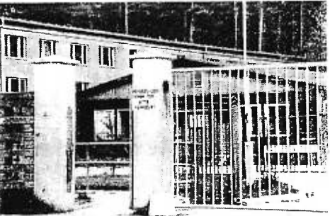
Die neue Unterkunft für die Asylanten in Hinrichshagen. Unbefugte haben keinen Zutritt, Sicherheitskräfte und Hunde wachen. 600 Menschen können hier untergebracht werden. Schon im Vorfeld wurde das Heim bereits als eine Notunterkunft genutzt. Die Bevölkerung von Hinrichshagen hat Bedenken zu der Entscheidung geäußert. Foto: PR
