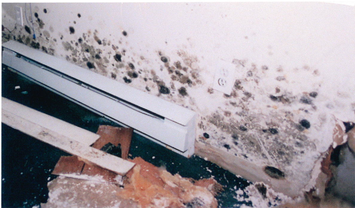
Figure 3. Aspect de murs contaminés par les moisissures suite à des inondations
