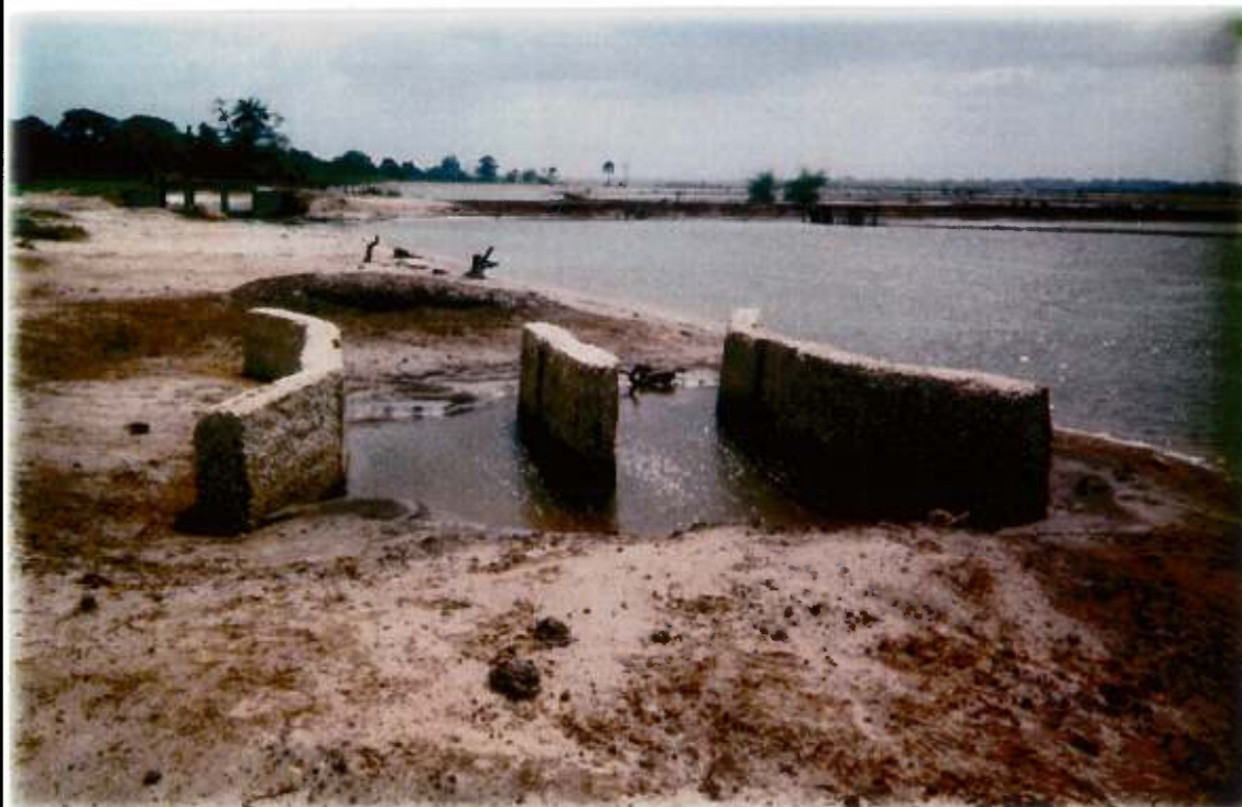
Restes d'un barrage PIDAC inachevé (Vallée de Diatang-Katoudié)
