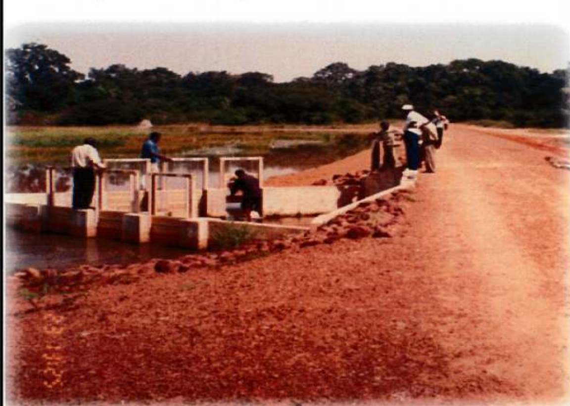
Vue sur la digue de rétention de Djimakakor
