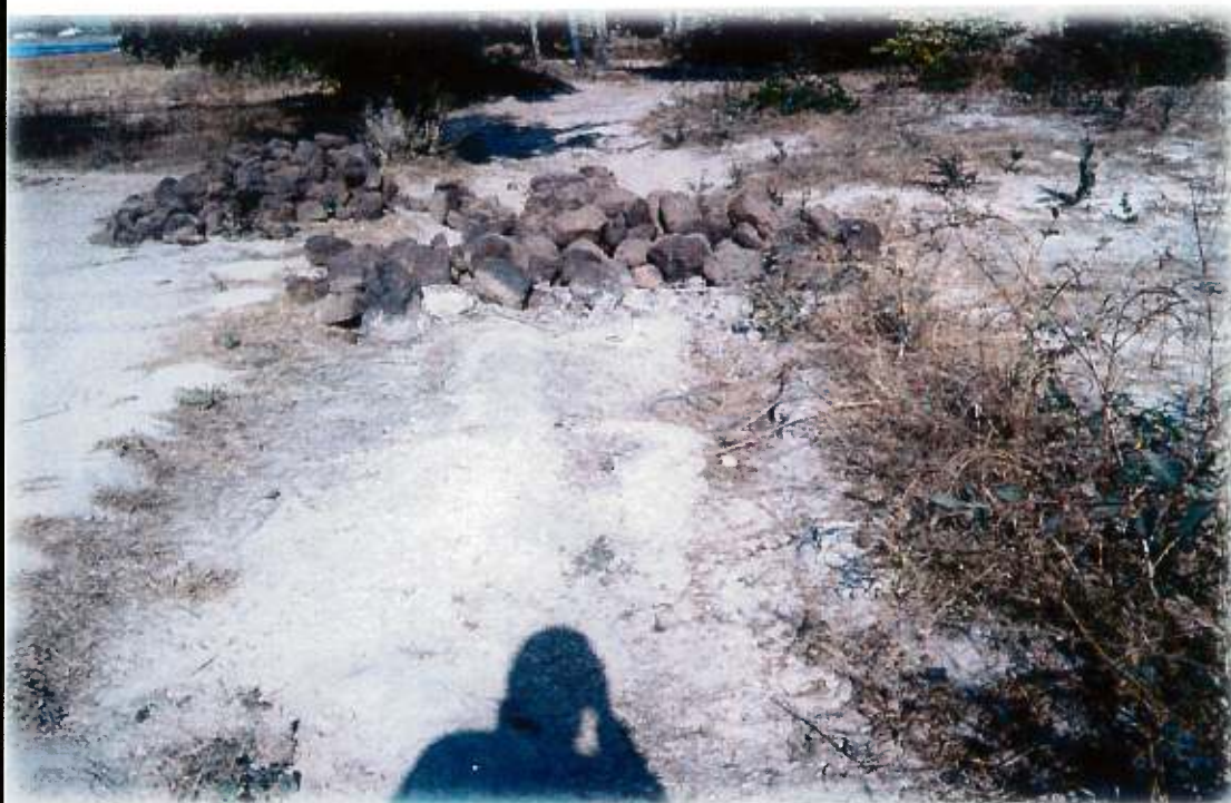
Pose de gabions pour freiner l'érosion et l'ensablement
