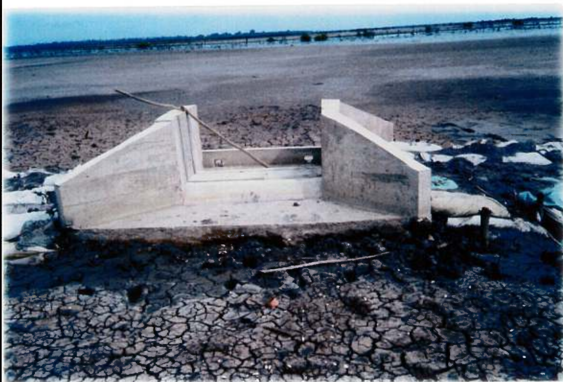
Figure 25 : Restes d'un barrage DERBAC inachevé (Vallée Ouongue)
