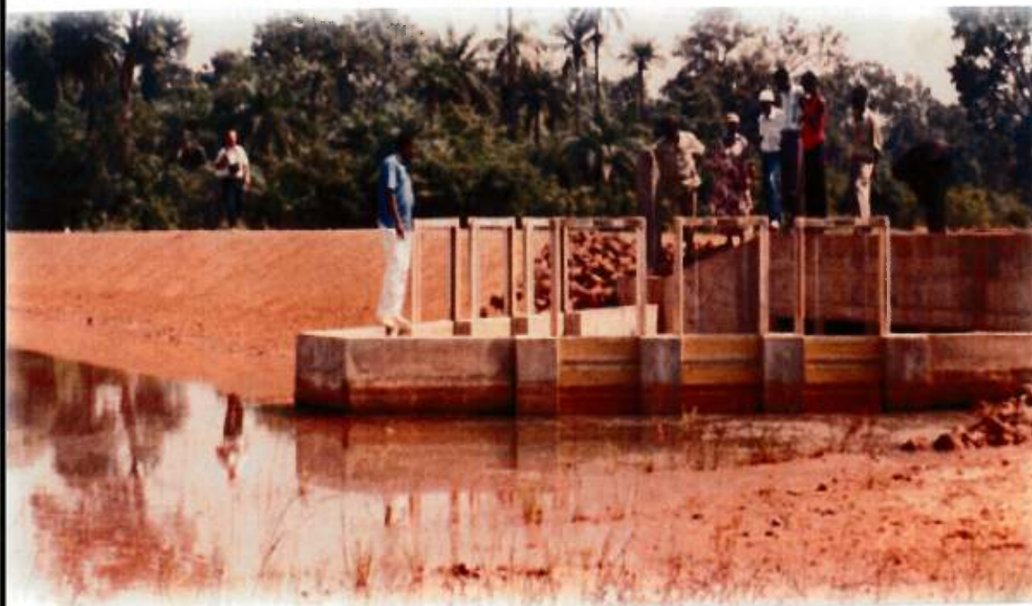
Figure 15 : Ouvrage évacuateur de la digue de rétention de Djimakakor
