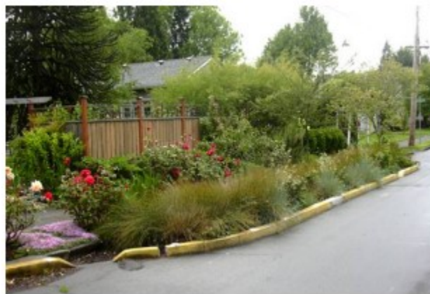
Figure 17 Les Green Streets de Portland assurent un drainage naturel des rues, en plus d'un embellissement du quartier. Source : Ville de Portland (2004). Disponible en ligne sur : https://www.portlandoregon.gov/bes/article/167583
