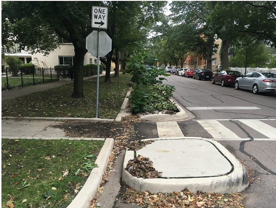
Figure 23 Exemple de système de drainage urbain durable (Sustainable Urban Drainage System, SUDS), un type d'IVB conçu spécifiquement pour la gestion des eaux pluviales en milieu urbain. Source : FISCHER, Eric (15 octobre 2017). Attribution CC BY 2.0 < https://creativecommons.org/licenses/by/2.0/ >, via Wikimedia Commons. Disponible en ligne sur : https://upload.wikimedia.org/wikipedia/commons/8/8b/Bioswale_and_curb_extension_with_cutouts_%2838067594726%29.jpg
