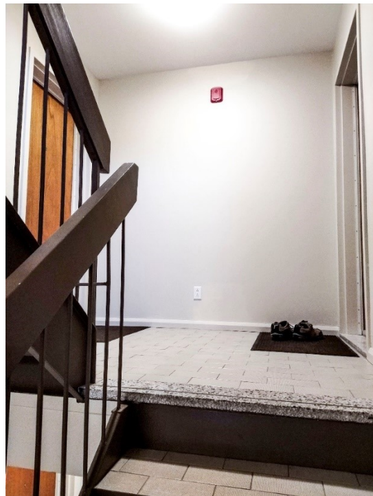
Photographie 39. « Ginette — Palier d'escalier avant »
