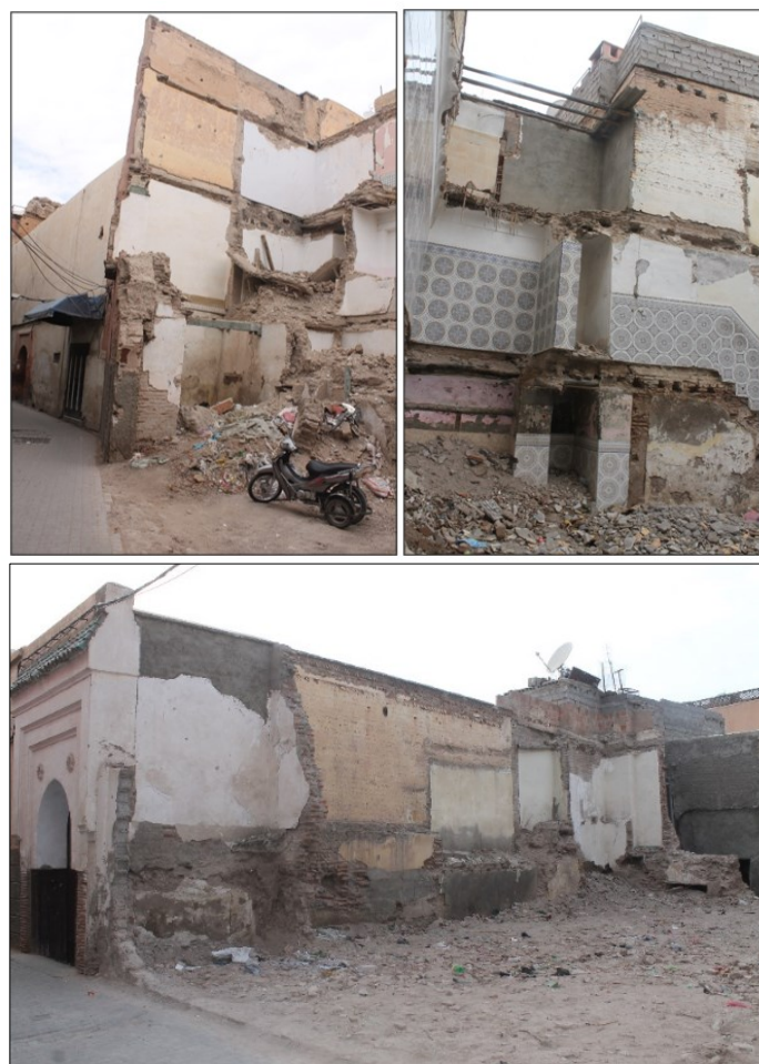
Figure 54: exemples de maisons achetées par des étrangers après démolition dans le cadre du programme de lutte contre les HMR.
