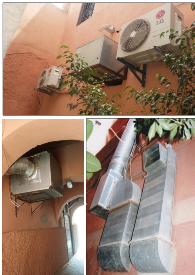
Figure 62: Climatiseurs et cheminées de fumée et d'aération extérieures installés sur des murs mitoyens des restaurants et maisons d'hôtes et des maisons des habitants.
