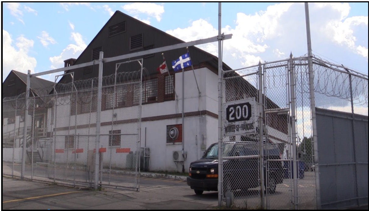
Figure 5. - Vue de l'entrée principale du CSI de Laval et d'une fourgonnette servant au transport des détenus. (Source de l'image : Agence des services frontaliers du Canada, 2016, reproduite avec permission)
