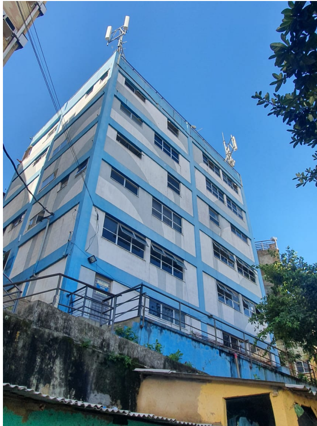
Figure 6. – Photo 0.3 Base de l'UPP Cantagalo Pavão-Pavãozinho
