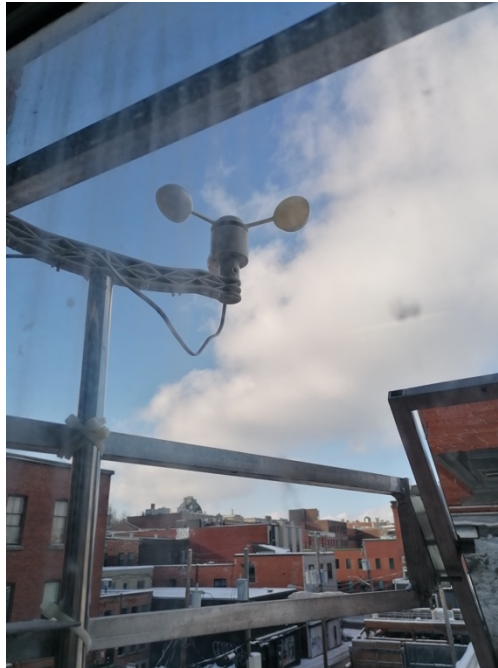
Figure 9. – Photo de l’anémomètre installé au centre d’Art Sporobole à Sherbrooke en janvier 2021.
