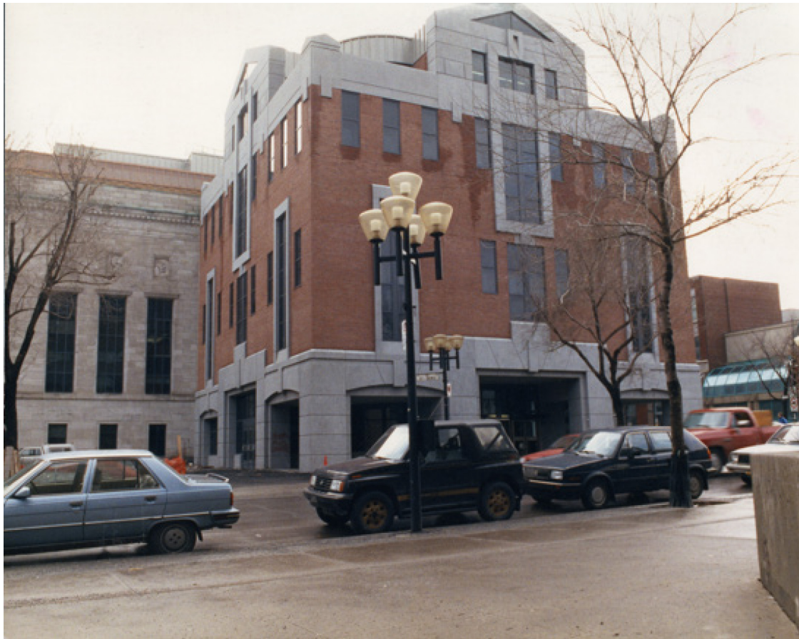
Figure 8 : Façade est du pavillon de Musique, rue St-Denis (Montréal), avril 1992 94 .
