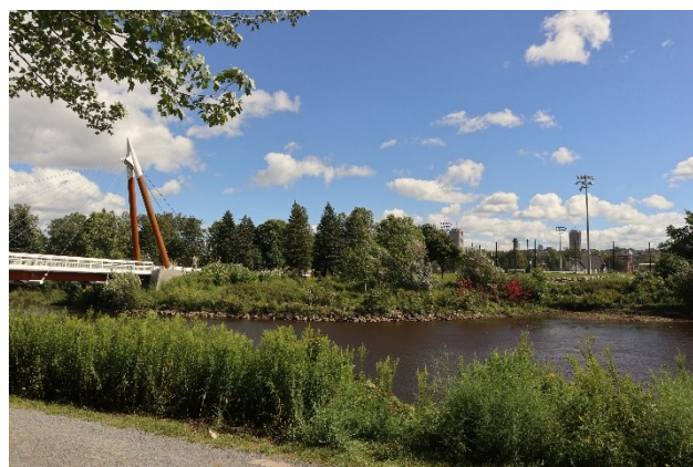
Figure 18. – Vue du pont piéton des Trois-Sœurs et arrière-plan urbain, Parc de la rivière Saint-Charles
