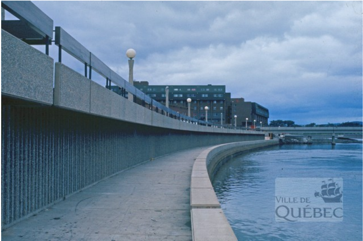
Figure 8. – Vue de la bétonisation des berges de la rivière Saint-Charles en 1973
