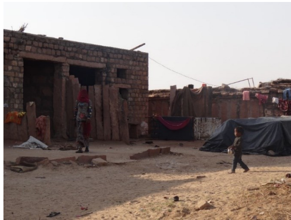
Figure 3.1 : Exemple de maison offerte par le gouvernement pour les familles Kalbeliya qui travaillent de manière saisonnière sur une terre. Photo : M.-S. Saulnier, 2017
