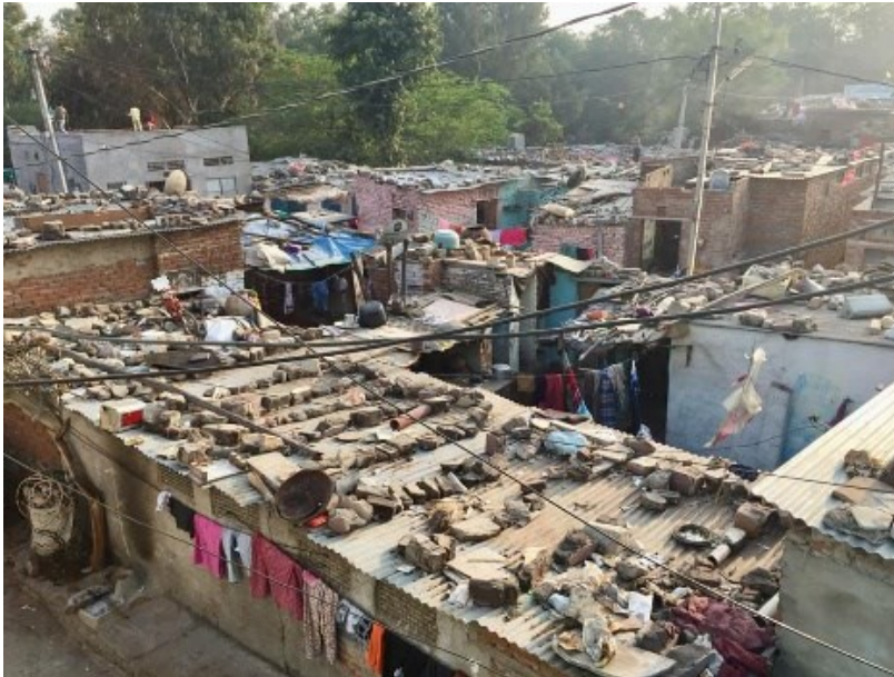
Figure 3.2 : Quelques maisons dans le Sangītakār colony . Photo : M.-S. Saulnier, 2018
