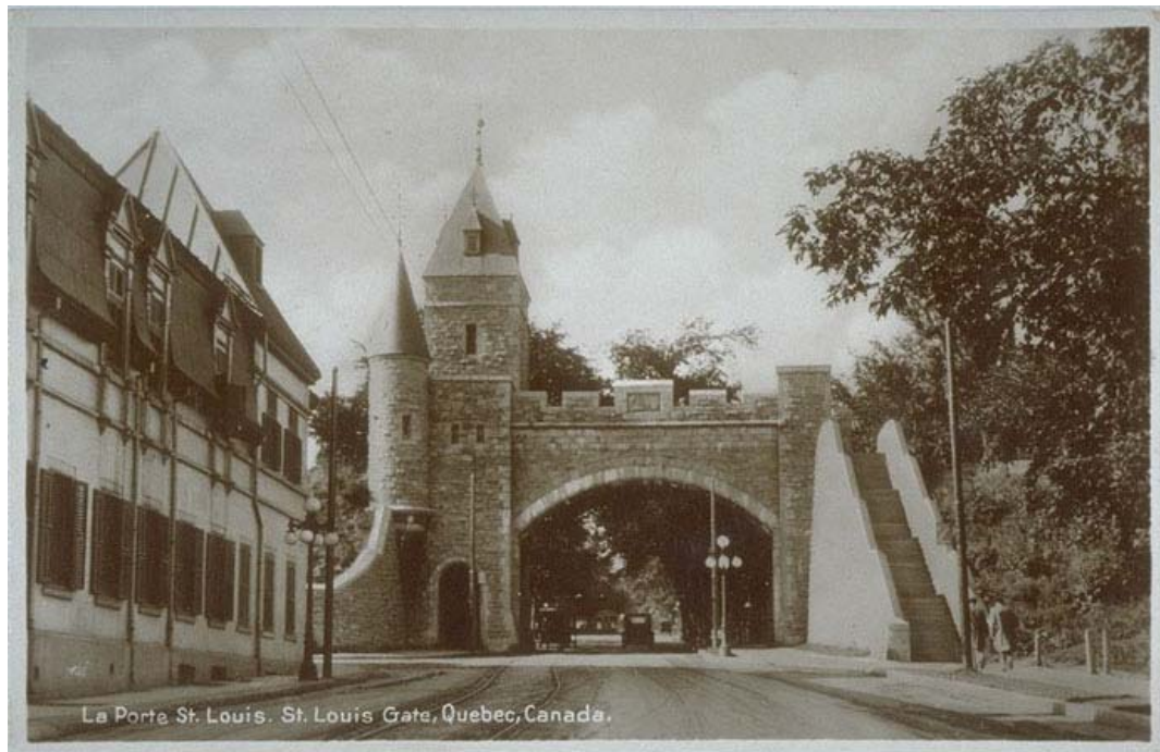
Figure 3 : La porte Saint-Louis et chemin de ceinture après reconstruction, date inconnue. Carte postale. Archives nationales du Québec
