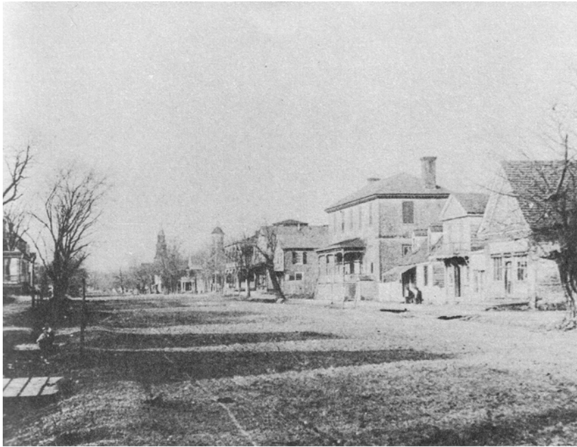
Figure 5 : Vue de Duke of Gloucester Street avant les travaux de démolition-reconstruction, Williamsburg, 1929.
