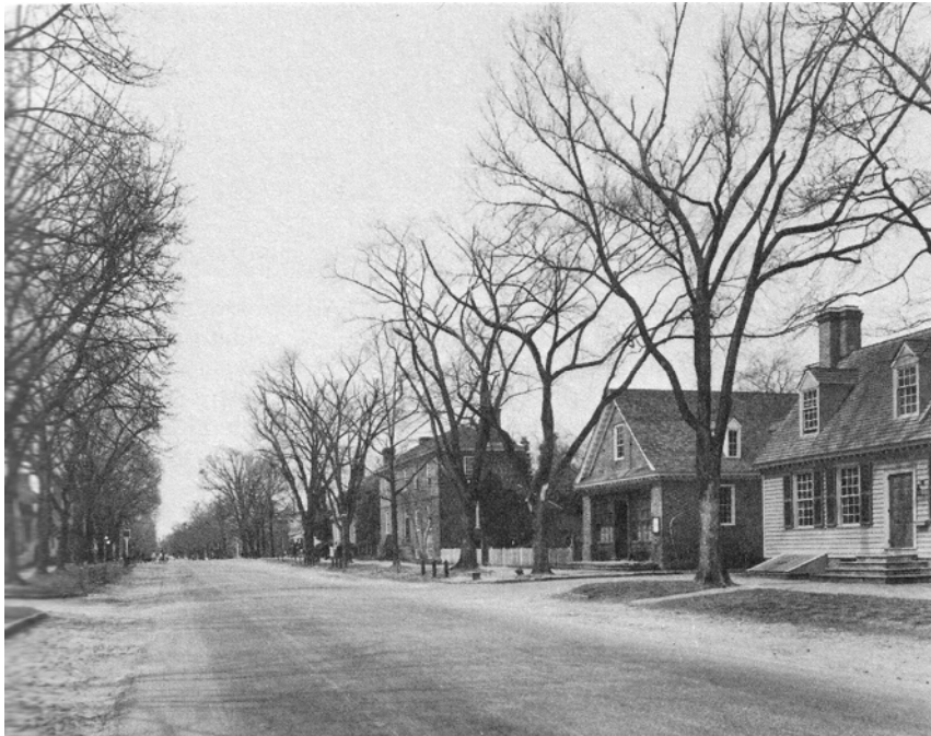
Figure 6 : Vue de Duke of Gloucester Street après les travaux de démolition-reconstruction, Williamsburg, 1965.
