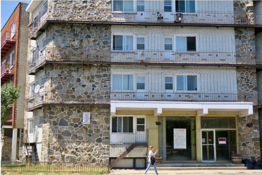
Figure 19 Détail des balcons et de l'auvent. Crédit photographique : Valérie Godbout
