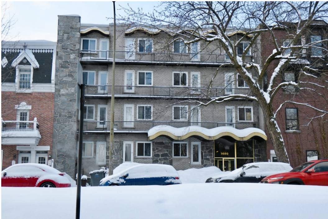
Figure 23 La façade du bâtiment avec ses deux auvents. Crédit photographique : Valérie Godbout
