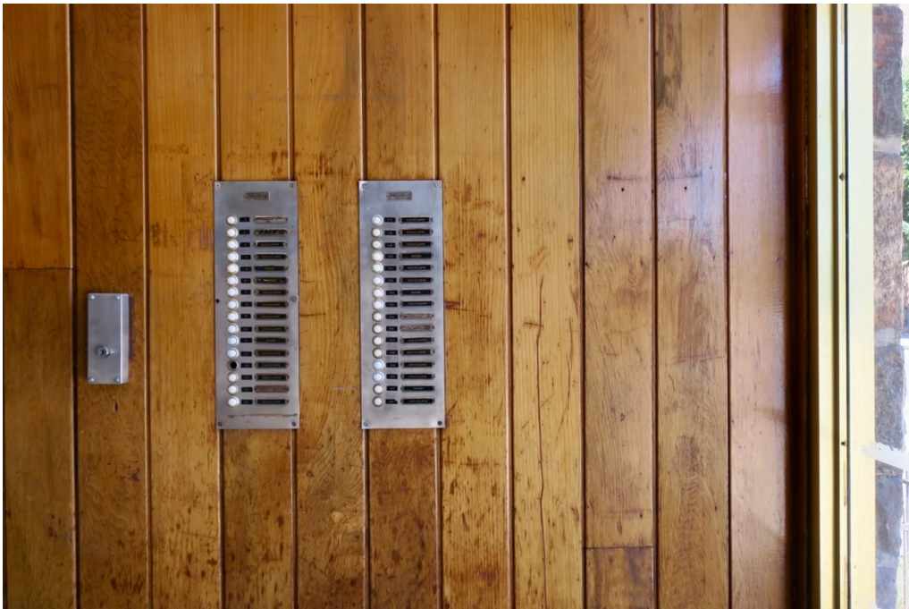
Figure 18 Détail de l'intercom et du revêtement de bois. Crédit photographique : Valérie Godbout
