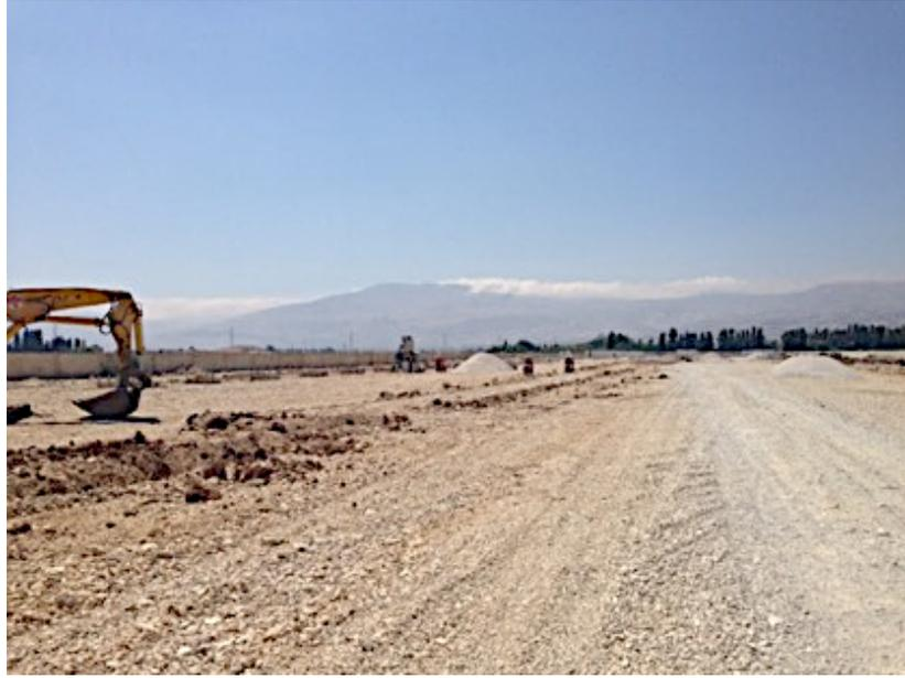
**Figure 3-66** : Nivellement du terrain et mise en place de l'infrastructure (Source : Kikano, 2014)
