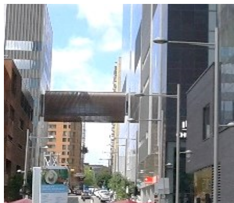
Figure 11. Liaison entre les pavillons (F) et (C) du nouveau CHUM. Vue sur la passerelle de liaison entre le pavillon F et C, nouveau CHUM. ©Z. Hammouni. 07 août 2018
