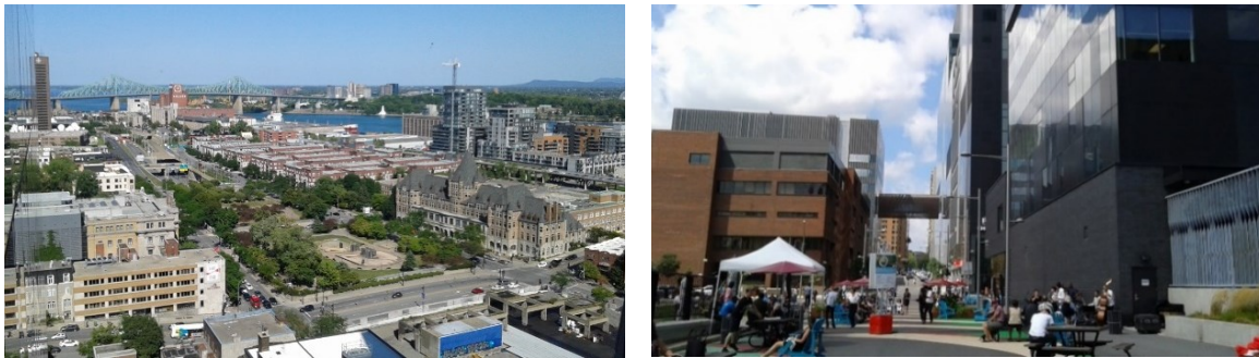
Figure 104. Alentours du nouveau CHUM. ©Z.Hammouni. À gauche, vue sur la ville de Montréal à partir du hall d'ascenseurs du personnel au 13 e étage- CHUM. À droite : Terrasse extérieure à la station métro Champ de Mars. 31 août 2018
