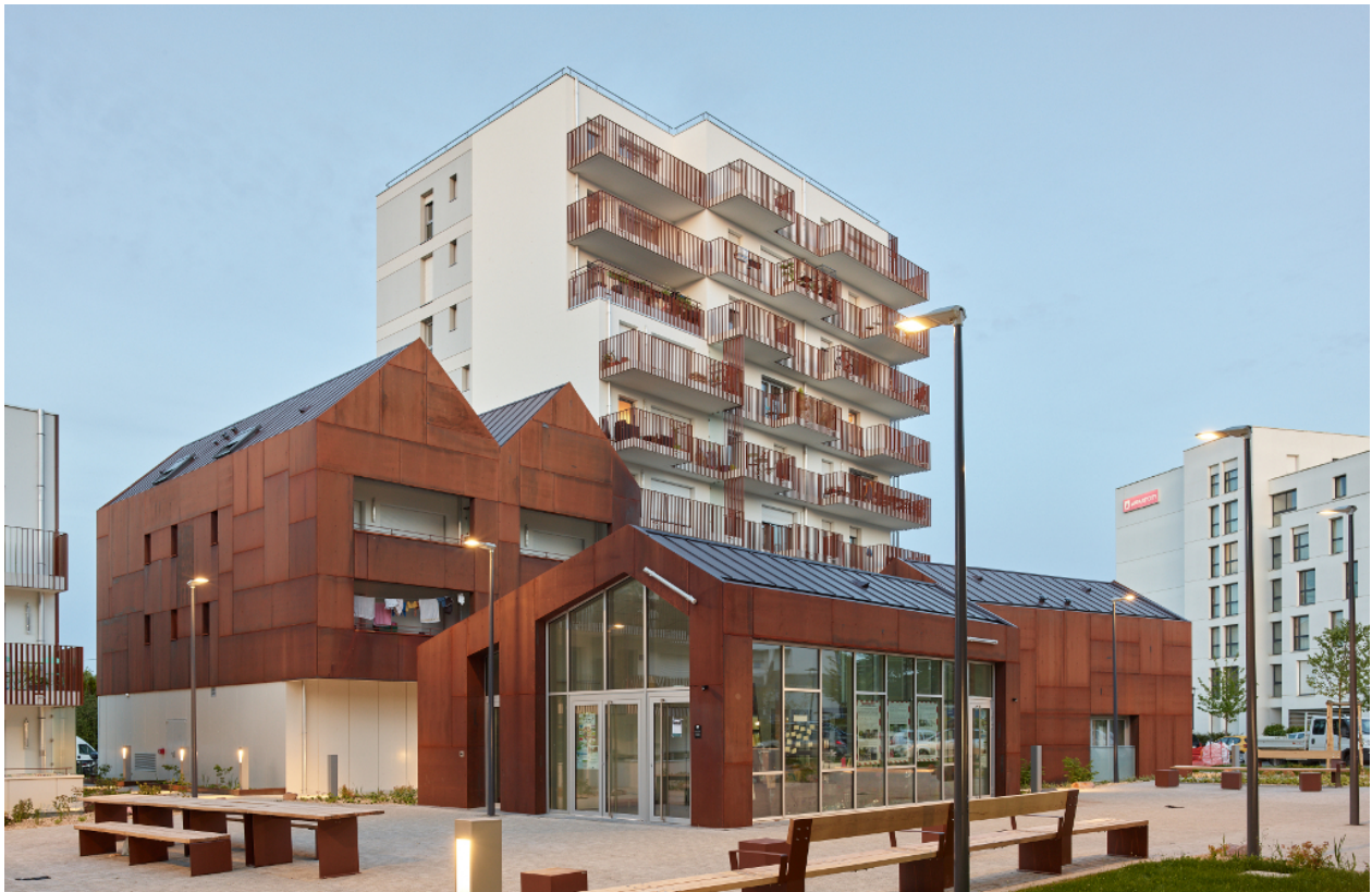
Figure 7 : Vue extérieure de la résidence le Cours des arts, Rennes. Chalmeau, S. (2019). Chroniques d'architecture. Reproduction utilisée repérée à : https://chroniques-architecture.com/le-cours-des-arts-zac-beauregard-lta/ . Consulté le 2020-10-26.
