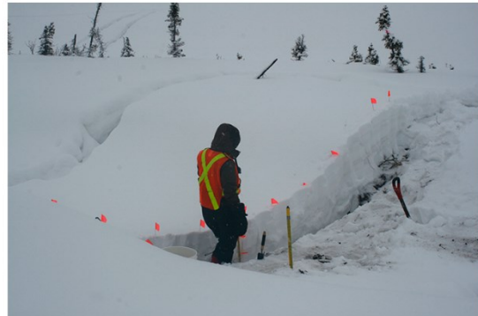
(d) Snow cover accumulation on embankment slope
