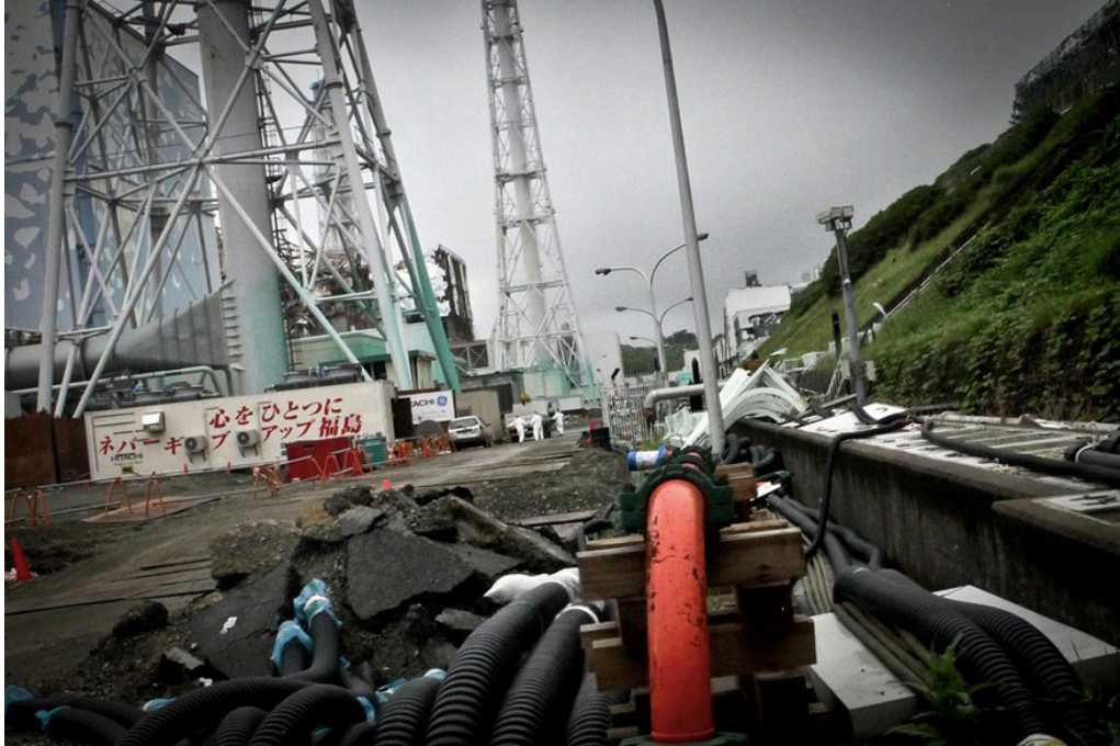
Figure 24. Obara Kazuma, photographie de la centrale Daiichi parue dans Die Zeit le 11 septembre 2011, accessible au https://www.zeit.de/wissen/2011-09/fs-inside-fukushima , image captée le 10 février 2019. © Obara Kazuma.
