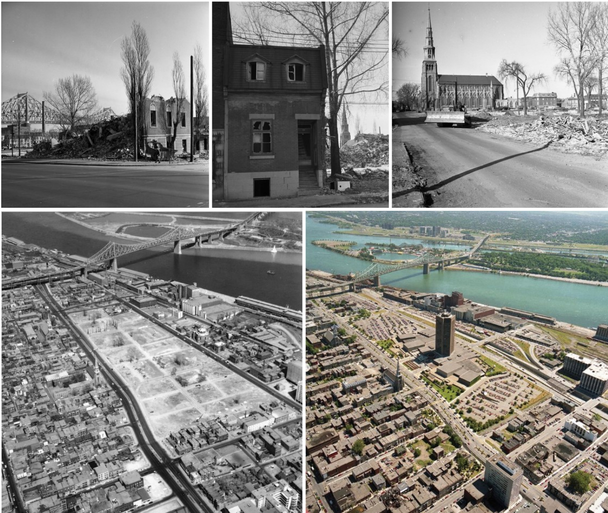
Figure 3 : Démolition d'une partie du Centre-Sud pour bâtir la Maison de Radio-Canada. De gauche à droite : destruction de l'hospice Sainte-Brigide (1963) au coin Alexandre-Desève et René-Lévesque, maison en ruines et carré de maison détruit (1963 ; emplacement inconnu), vue aérienne du site déblayé de la future Maison de Radio-Canada (1964) et Maison de Radio-Canada (1984).
