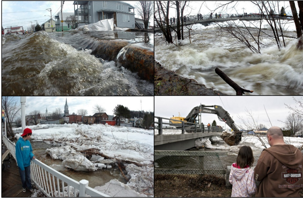
Figure 14. Dommages causés par l'inondation de 2014 au centre-ville de Saint-Raymond
