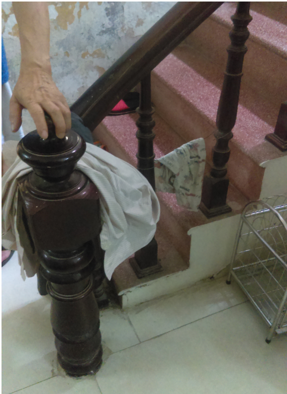
Figure 40 : Surhaussement du plancher d'une maison villageoise (source : auteur, 2017)
