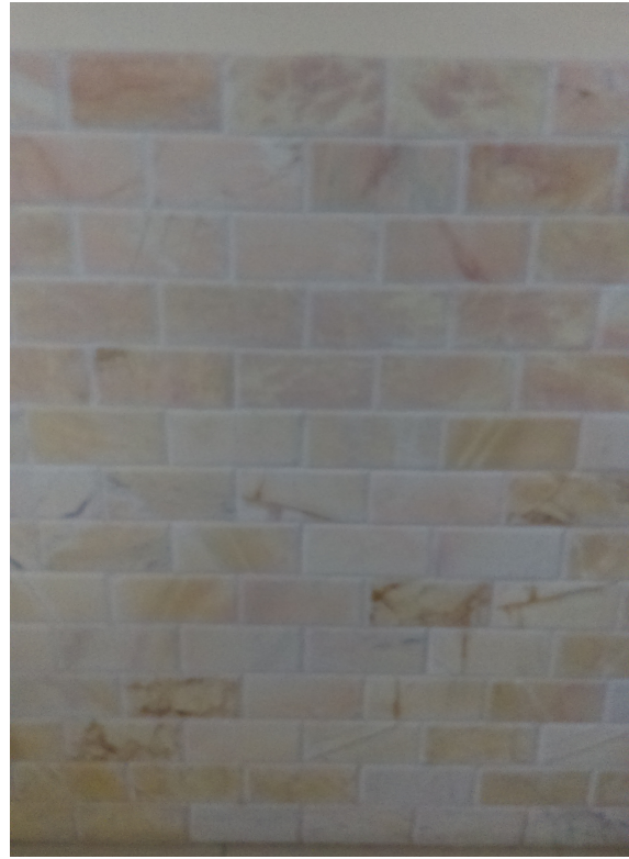
Figure 41 : Revêtement de mur intérieur en céramique (source : auteur, 2017)
