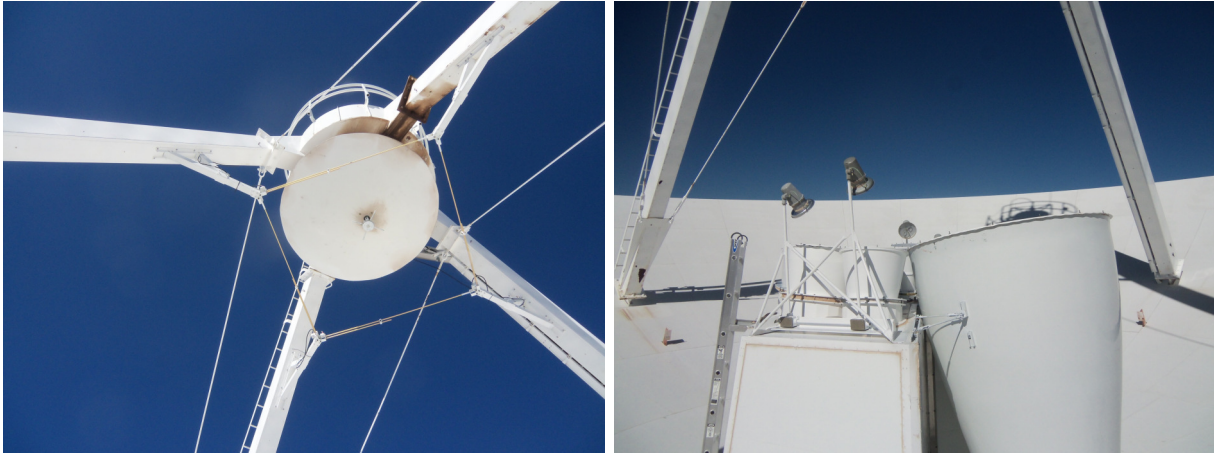
FIGURE 2.4. Gauche : Le réflecteur secondaire de 2.3 m de diamètre sur l'une des antennes du JVL A est de forme convexe et réfléchit les ondes radio dans l'un des guides d'ondes situé au centre de l'antenne. Au centre du réflecteur secondaire est fixée une antenne dipolaire qui capte le signal de la bande de fréquence de 330 MHz (bande P). Droite : Un anneau de guides d'ondes est situé au centre de chaque antenne. Pour une bande de fréquence donnée, le guide d'onde est sélectionné en pivotant le réflecteur secondaire. Le plus grand cornet d'alimentation visible à droite est celui de la bande L (1.5 GHz).
