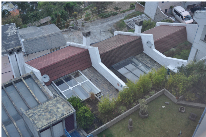
Figure 5.15. Vue extérieure des toitures avec vitres sur les patios (2016). Photographie de l'auteur.
