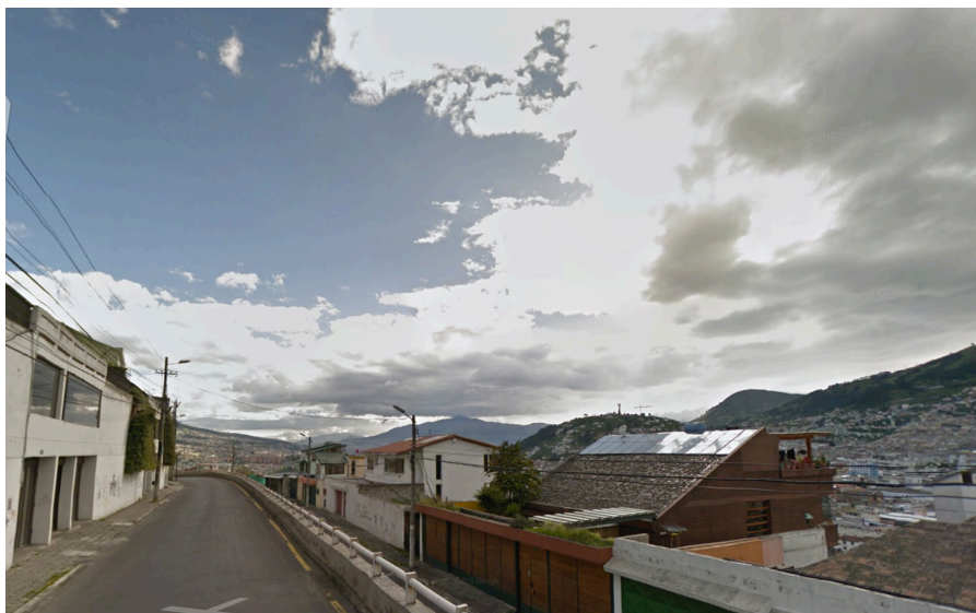
Figure 4.12. Tronçon de la rue Valparaíso avec la maison Díaz à son côté ouest. Tiré de Google Earth. Consulté le 14 juin 2017.
