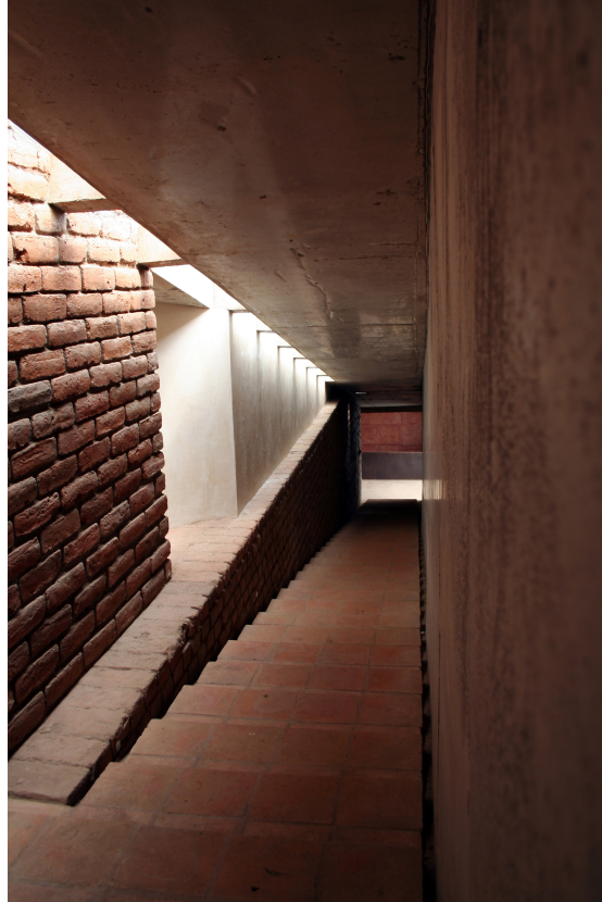
Figure 4.25. Escalier d'accès depuis le garage mi-creusé dans la cangahua, adjacent au jardin et longeant le mur limitrophe à la rue Carchi.
