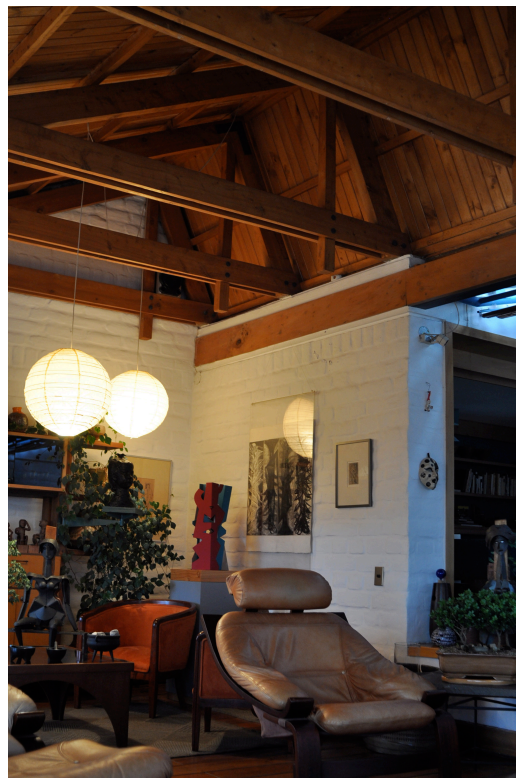
Figure 5.11. Vue intérieure de la toiture dans la résidence de l'architecte Jaime Andrade (2016). Photographie de l'auteur.
