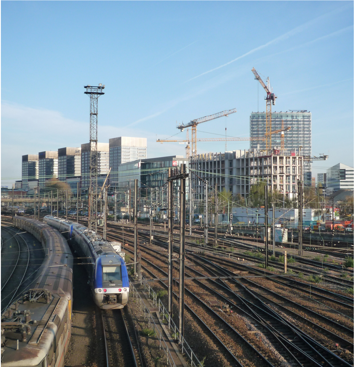
Figure 3 : Construction du projet Euralille, réalisé par l'Office for Metropolitan Architecture (OMA), entre 1989 et 1994 (Source: Wikimedia Commons).
