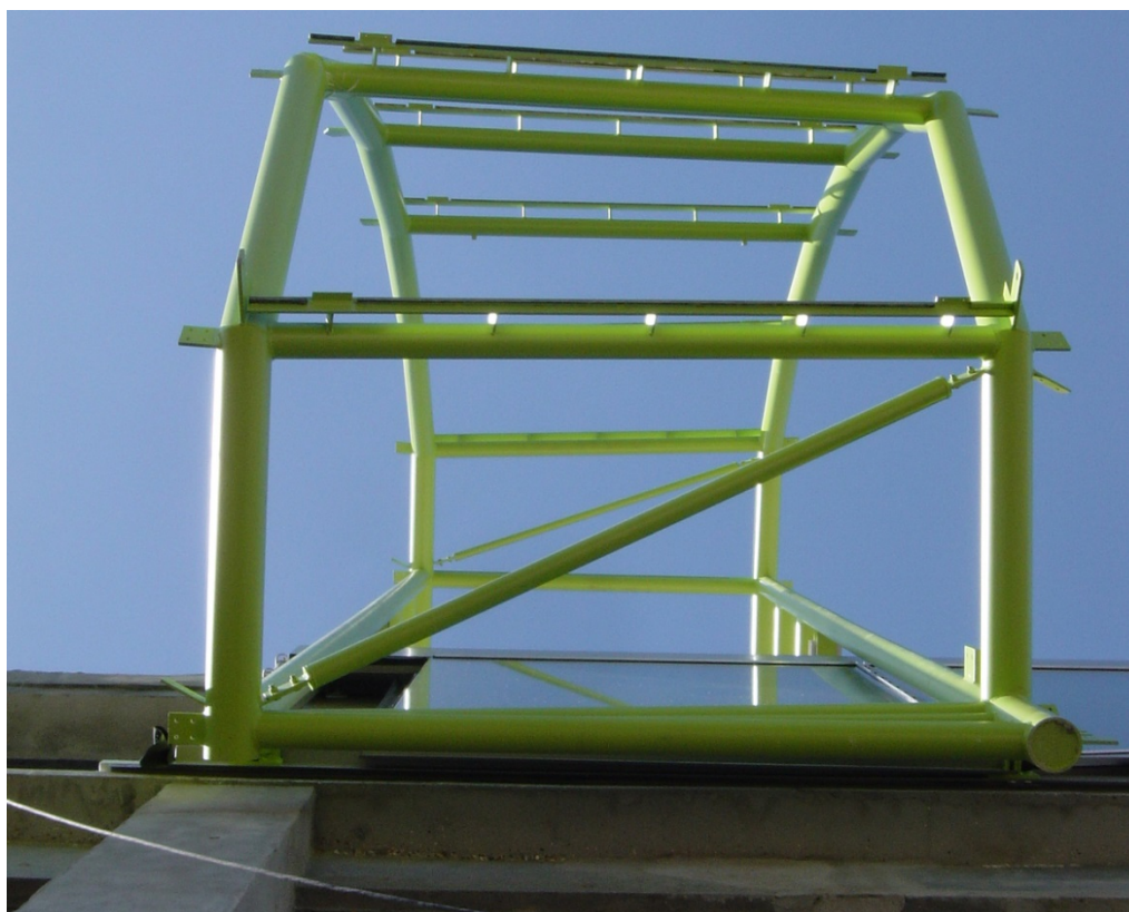
Figure 39 : Jakob+MacFarlane, Docks en Seine, Cité de la mode et du design, Paris, 2004-2008. Un module composé de deux poutres verticales avec des traverses soudées, avant la pose du vitrage. Photographie de chantier, 5 septembre 2007. Source : archives professionnelles de Jakob+MacFarlane
