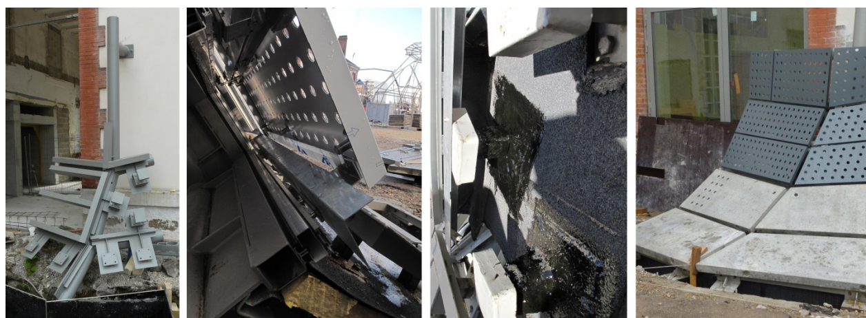
Figure 90: Jakob+MacFarlane, Les Turbulences, Frac-Centre, Orléans, 2006-2013. Étapes de fabrication du prototype d'enveloppe, photographies de chantier, du 25 août 2010 au 27 janvier 2011. Source : archives professionnelles de Jakob+MacFarlane.
