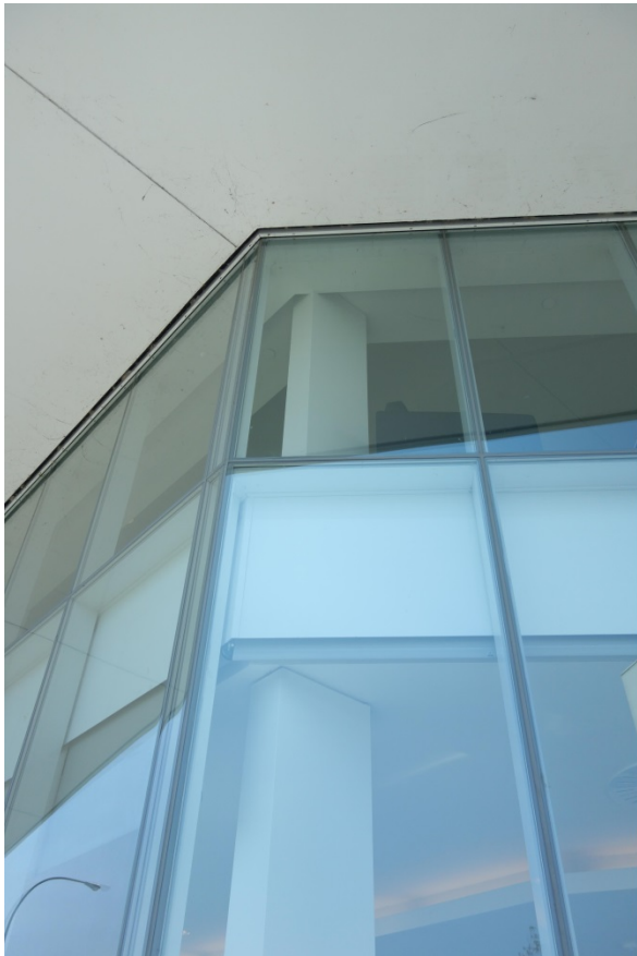
Figure 15 : Chevalier Morales Architectes, Agrandissement de la bibliothèque Saul-Bellow, Arrondissement Saint-Laurent, Montréal (QC), 2011-2015. A. Traitement du nez de dalle vu depuis l'extérieur. B. L'enveloppe composite du bandeau de la toiture. Photographie de chantier, 4 novembre 2014. Photographies de l'auteur
