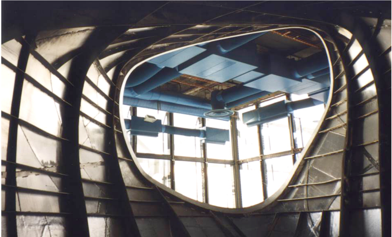
Figure 14 : Jakob + MacFarlane, Restaurant Georges, 1998-2000. La charpente en aluminium des coques avant la pose du revêtement intérieur en caoutchouc. Photographie de chantier. Source : Archives professionnelles de Jakob+MacFarlane
