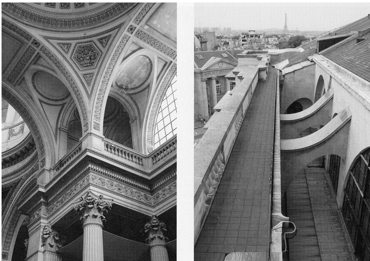
Figure 14 : Jacques Germain Soufflot, Église Sainte Geneviève, 1756-1790. A. Retombées des voûtes à l'intersection de la nef et du dôme. B. Les arcs-boutants reprenant la poussée latérale des voûtes dissimulés à l'arrière de l'acrotère. Source Levine, Neil. Modern Architecture . Op.cit.
