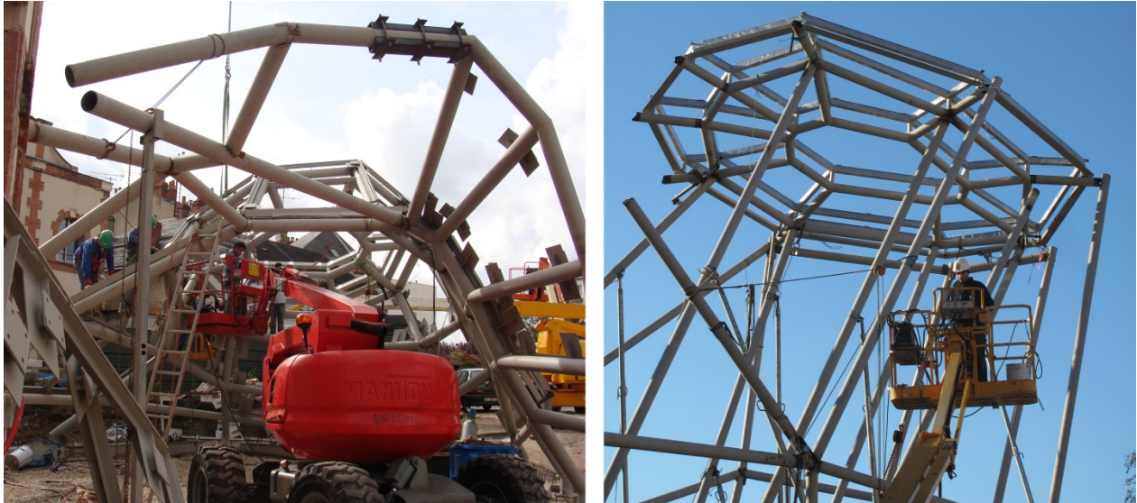
Figure 91: Jakob+MacFarlane, Les Turbulences, Frac-Centre, Orléans, 2006-2013 Montage de la charpente tubulaire, photographies de chantier, A. 30 septembre 2010, B. 9 décembre 2010. Source : Archives professionnelles de Jakob+MacFarlane.
