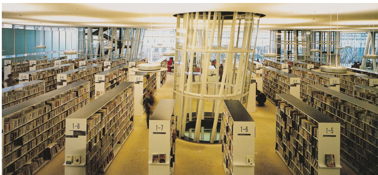
Figure 2 : Vue du 2ème étage [3 rd floor] de la bibliothèque en activité. Les supports verticaux ont conservé leur transparence, mais ont perdu l'apparence d'un treillis. Source : Ito, Toyo. Sendai Mediatheque , Barcelona, Actar, 2003
