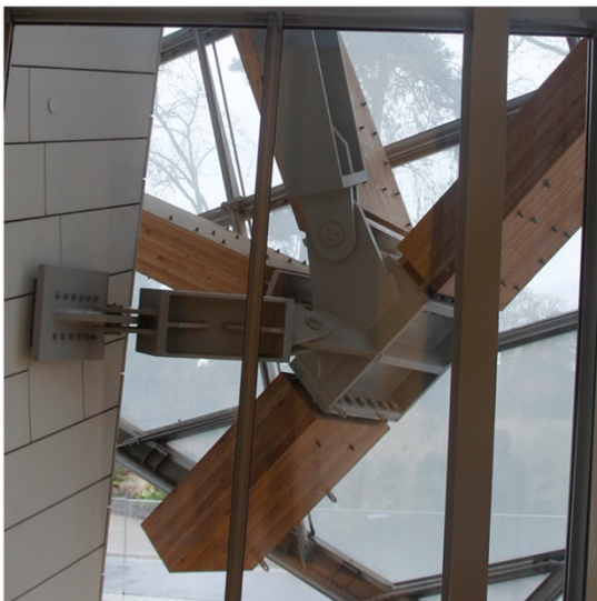
Figure 5 : Gehry Partners LLP architects ; Gehry Technologies ingénieurs, Fondation LVMH, Paris, 2016. Détails de connecteurs métalliques entre les pièces de charpente. Photographies de l'auteur.
