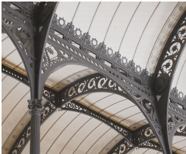
Figure 3 A. Charpente métallique (fonte) de la bibliothèque Sainte Geneviève, Henri Labrouste, 1851 B. Charpente métallique (fer forgé) de la Bibliothèque Royale, Henri Labrouste, 1875
