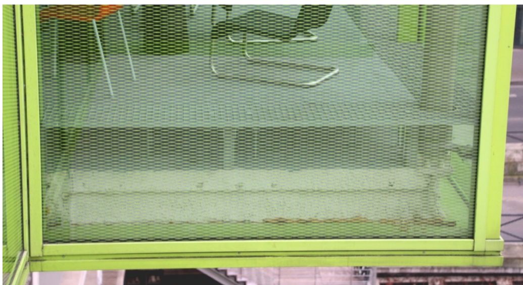
Figure 45: Jakob+MacFarlane, Docks en Seine, Cité de la mode et du design, Paris, 2004-2008. Vue d'un bloc en porte-à-faux sur la façade ouest depuis la coursive du « plug-over ». Photographie de l'auteur.
