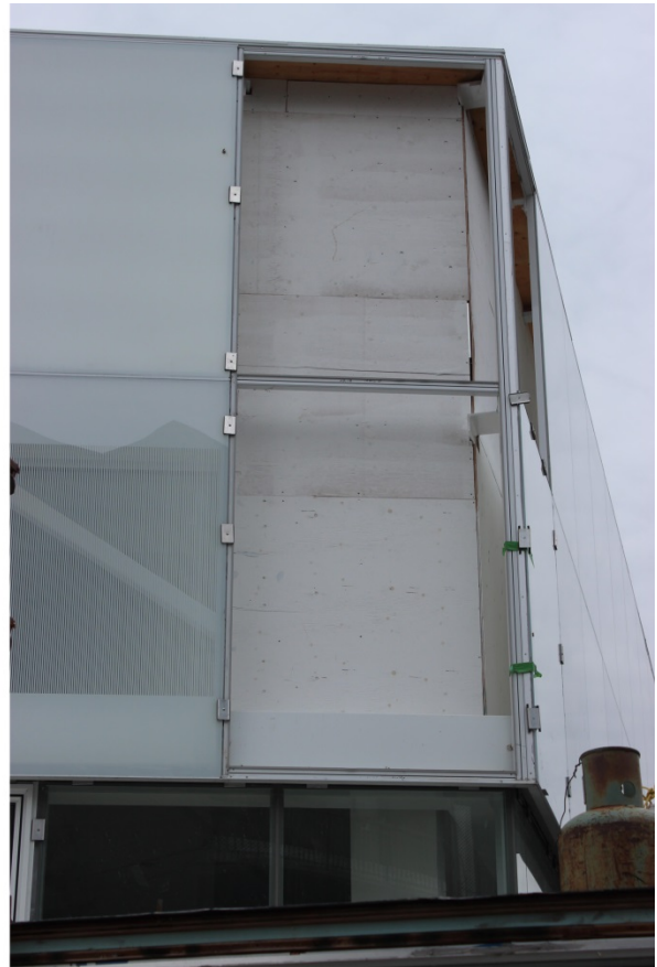
Figure 15 : Chevalier Morales Architectes, Agrandissement de la bibliothèque Saul-Bellow, Arrondissement Saint-Laurent, Montréal (QC), 2011-2015. A. Traitement du nez de dalle vu depuis l'extérieur. B. L'enveloppe composite du bandeau de la toiture. Photographie de chantier, 4 novembre 2014. Photographies de l'auteur
