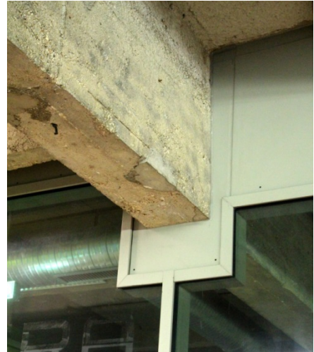
Figure 35 : Jakob+MacFarlane, Docks en Seine, Cité de la mode et du design, Paris, 2004-2008. Détail de la jonction entre les huisseries des cloisons vitrées et l'ossature de béton armé. Photographie de l'auteur.
