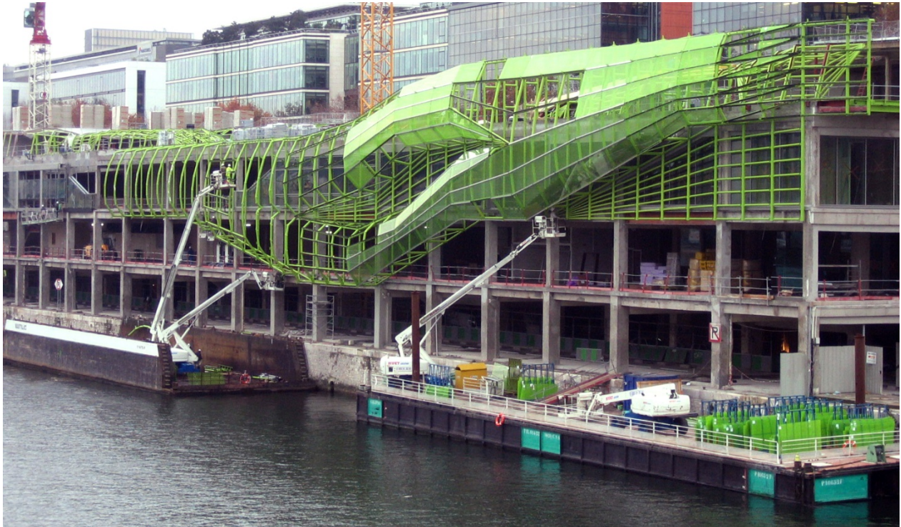
Figure 58: Jakob+MacFarlane, Docks en Seine, Cité de la mode et du design, Paris, 2004-2008. Chaîne de montage du plug-over, d'ouest en est : poutres verticale, pannes, vitrage, capots Photographie de chantier, 5 septembre 2007. Source : archives professionnelles de Jakob+MacFarlane
