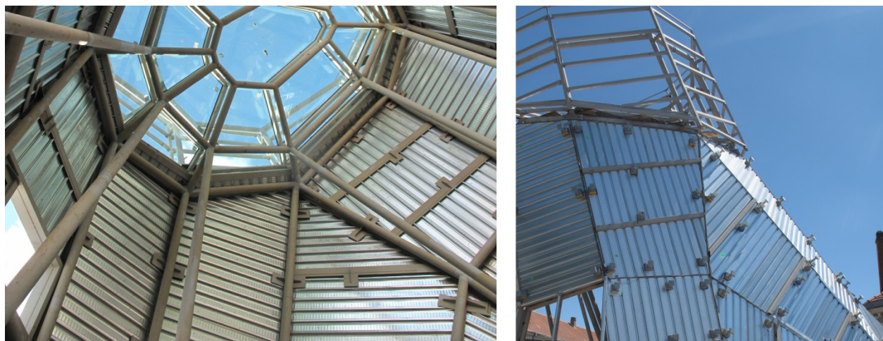
Figure 88 : Jakob+MacFarlane, Les Turbulences, Frac-Centre, Orléans, 2006-2013. Pose des bacs acier de l'enveloppe, photographies de chantier, 30 juin 2011. Source : archives professionnelles de Jakob+MacFarlane.
