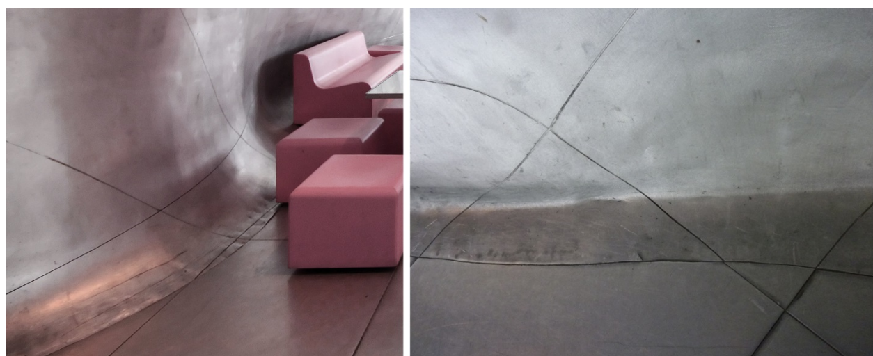
Figure 5: Jakob+MacFarlane, Restaurant Georges, Centre Pompidou, Paris 1998-2000. Détails de la jonction entre les poches et le dallage. Photographies de l'auteur
