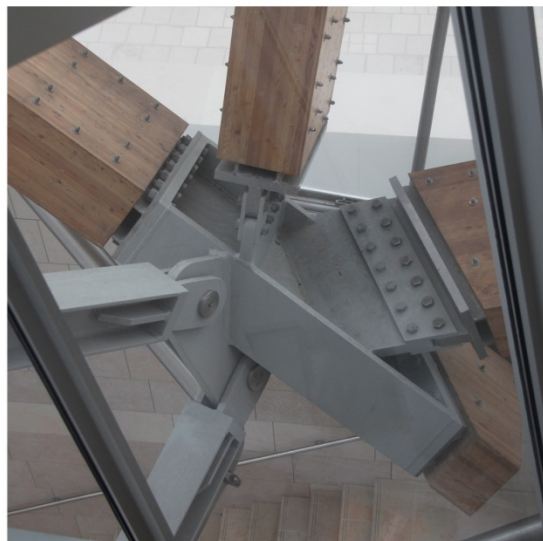
Figure 5 : Gehry Partners LLP architects ; Gehry Technologies ingénieurs, Fondation LVMH, Paris, 2016. Détails de connecteurs métalliques entre les pièces de charpente. Photographies de l'auteur.
