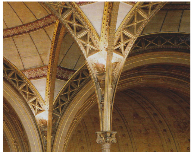
Figure 3 A. Charpente métallique (fonte) de la bibliothèque Sainte Geneviève, Henri Labrouste, 1851 B. Charpente métallique (fer forgé) de la Bibliothèque Royale, Henri Labrouste, 1875
