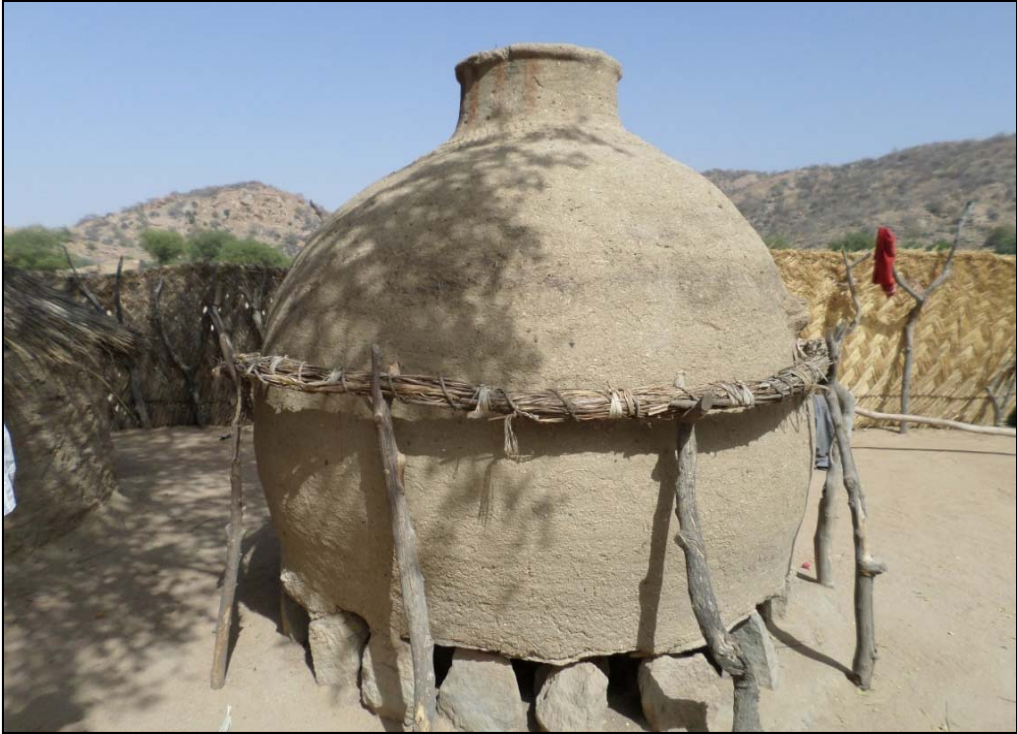
Grenier de terre séchée (cliché de Wilfried)
