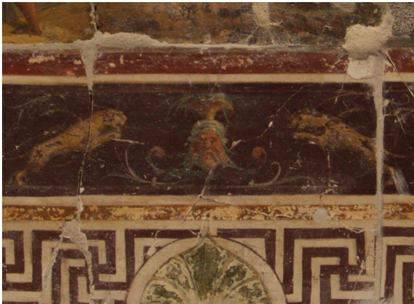
Figure 20. Cercle de Luzio Luzzi (?), détail du 3 ème compartiment, plafond de la loggia, v. 1547, Palazzo della Loggia, Bagnaia.
